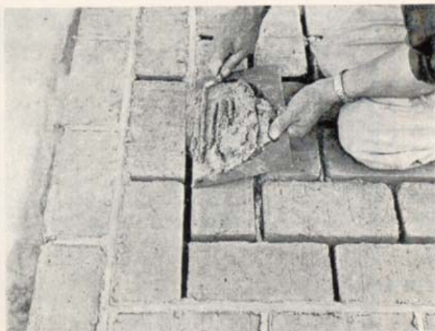
Fugerne fyldes og stryges med fugeske af stål.
