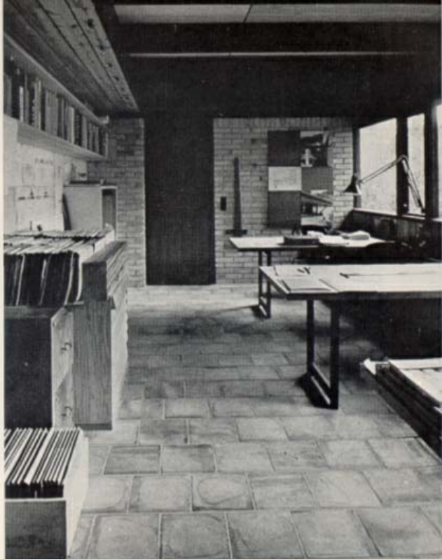
Ubehandlet teglgulv af tegldæk-vederlagsblokke (arkitekt m. a. a. Bertel Udsen, egen tegnestue).
