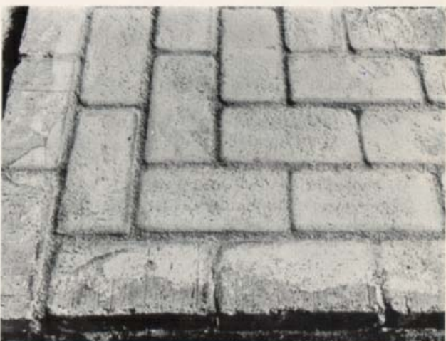
Synker fugemörtlen, må behandlingen gentages. Mørtlen på stenene slibes af ved den efterfølgende maskinslibning.
