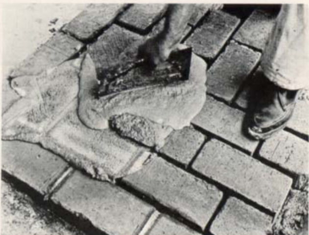
Fugemörtlen fordeles over gulvet med gummispartel eller tilsvarende, der føres diagonalt over fugerne.
