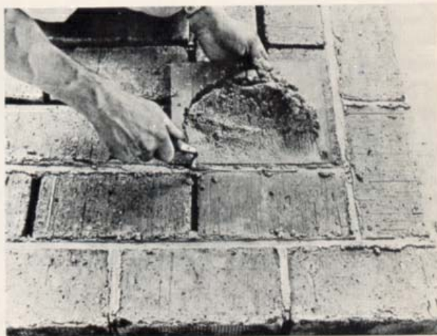
Arbejdet udføres omhyggeligt og forsigtigt, så mørtlen ikke tilsmudser tegloverfladen. Mørtelkanter i fugerne kan fjernes med stiv børste, når mørtlen er tør.
