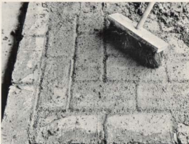
Også piassavakost kan benyttes til fordeling af fugemörtlen. Børstningen sker diagonalt i forhold til fugerne.
