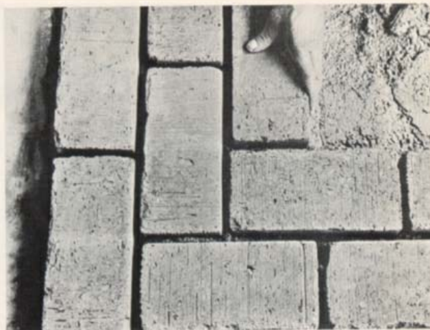
Det er praktisk at trykke lidt af læggemørtlen op i fugen ved at trykke stenen skråt ind på plads fra siden.
