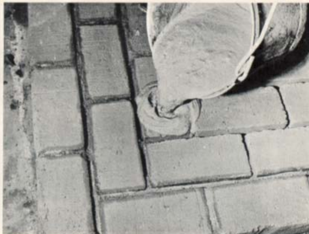
Mørtel i vællingskonsistens hældes ud over gulvet.
