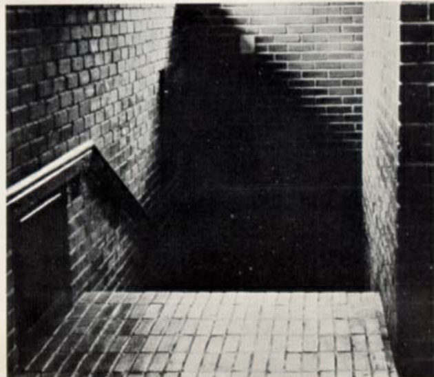
Blankbehandlet teglgulv i trapperum på skole.
