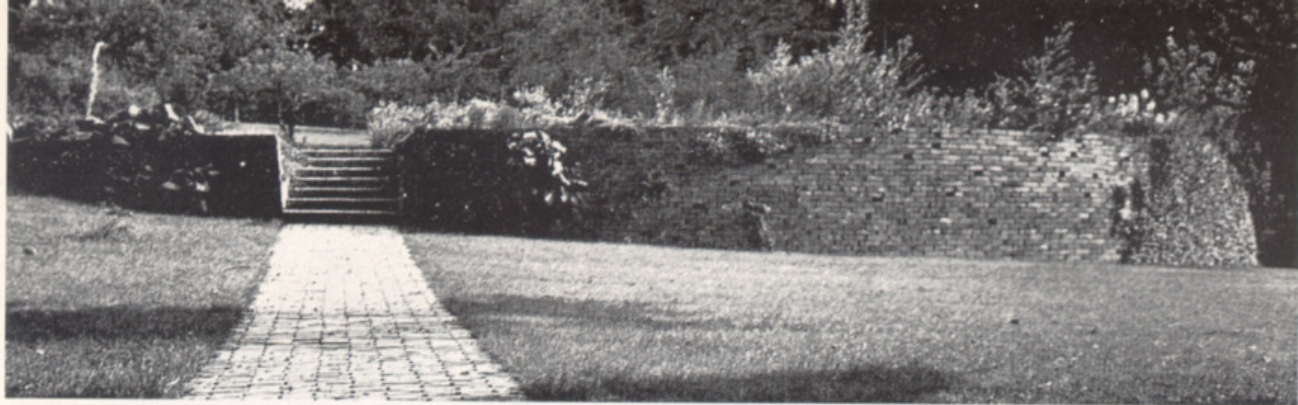
Støttemur med indbygget trappe
