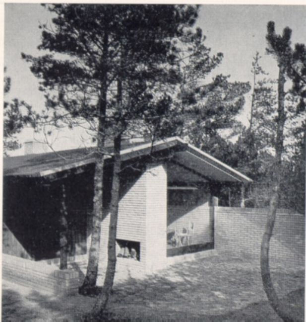
Fritstående ildsted opbygget af murstensklinker
