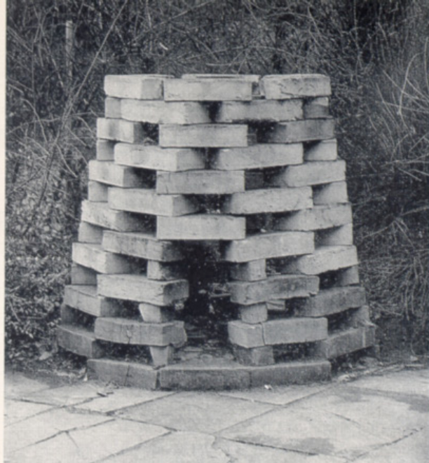
Fritstående ildsted opbygget af murstensklinker
