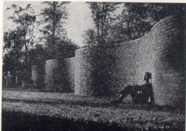
Slynget læ- og hegnsmur i et større haveanlæg
