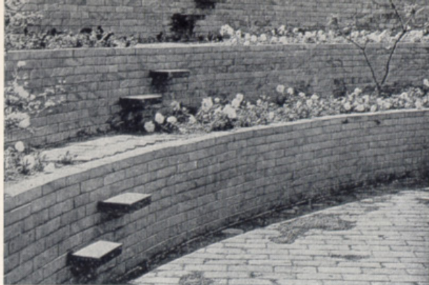
Aftrappede støttemure med indstukne betontrin
