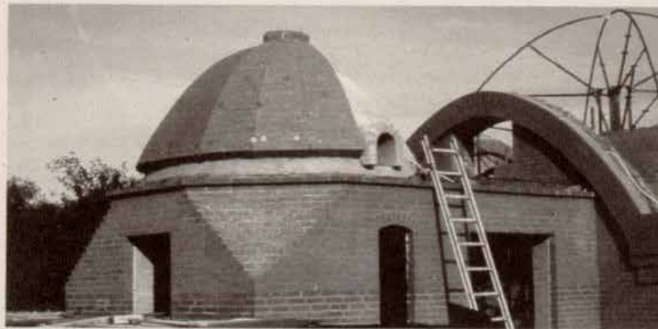
Kuplen afdækkes med Rockwool, der pudses med fiberbeton.
