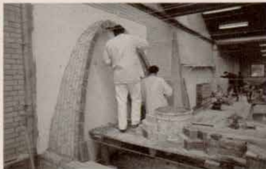
Opmuring af hvælv på Teknisk Skole i Slagelse
