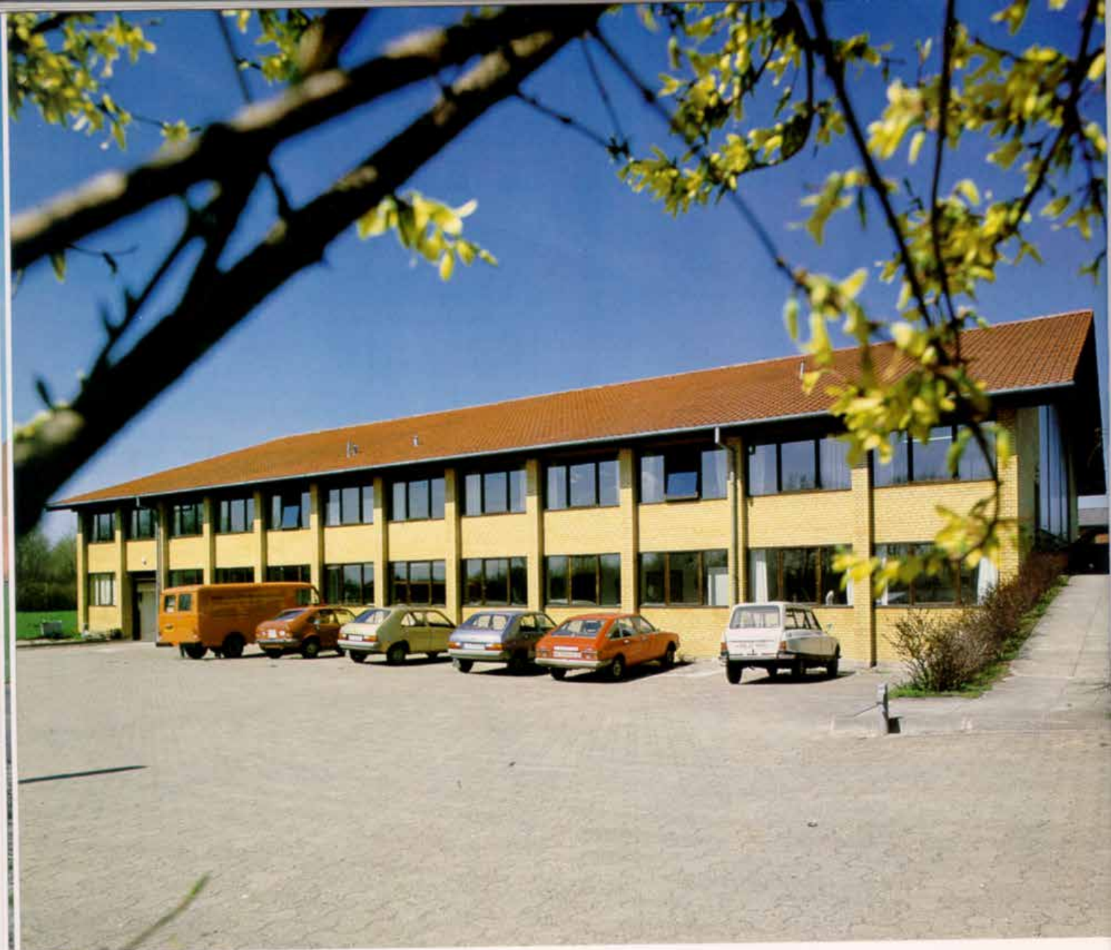
Bygningen set fra parkeringspladsen (syd)
