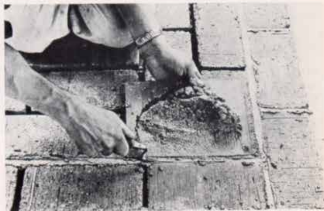
Arbejdet udføres omhyggeligt og forsigtigt, så mørtlen ikke tilsmudser tegloverfladen. Mørtelkanter i fugerne kan fjernes med stiv børste, når mørtlen er tør.
