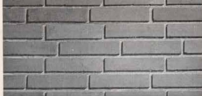
Løberforbandt med \frac{1}{4} stens spring, maskinstregne sten
