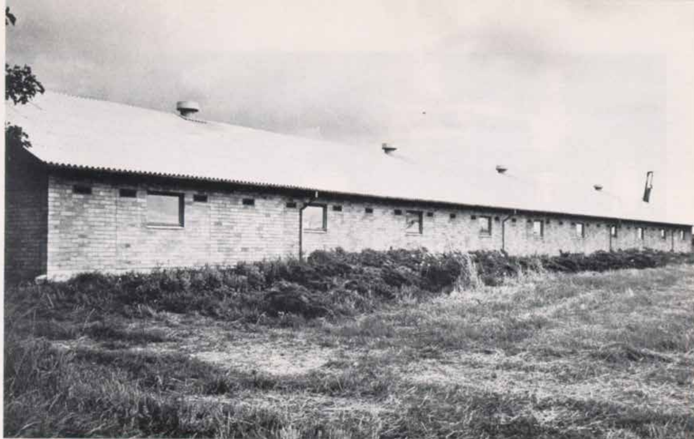
Ydermuren af Lamelteglelementer opbygget af teglhulblokke.
