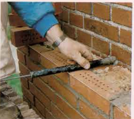
Figur 10. Udstøbning af hul til murbinder.
