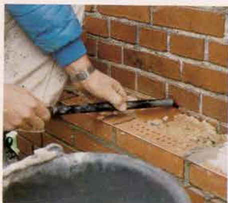
Figur 9. Rensning og forvanding af hul til murbinder.
