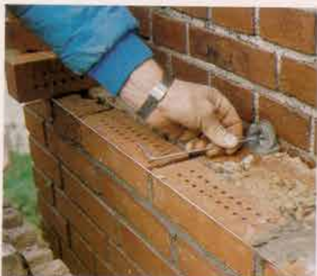
Figur 11. Indpresning af murbinder.
