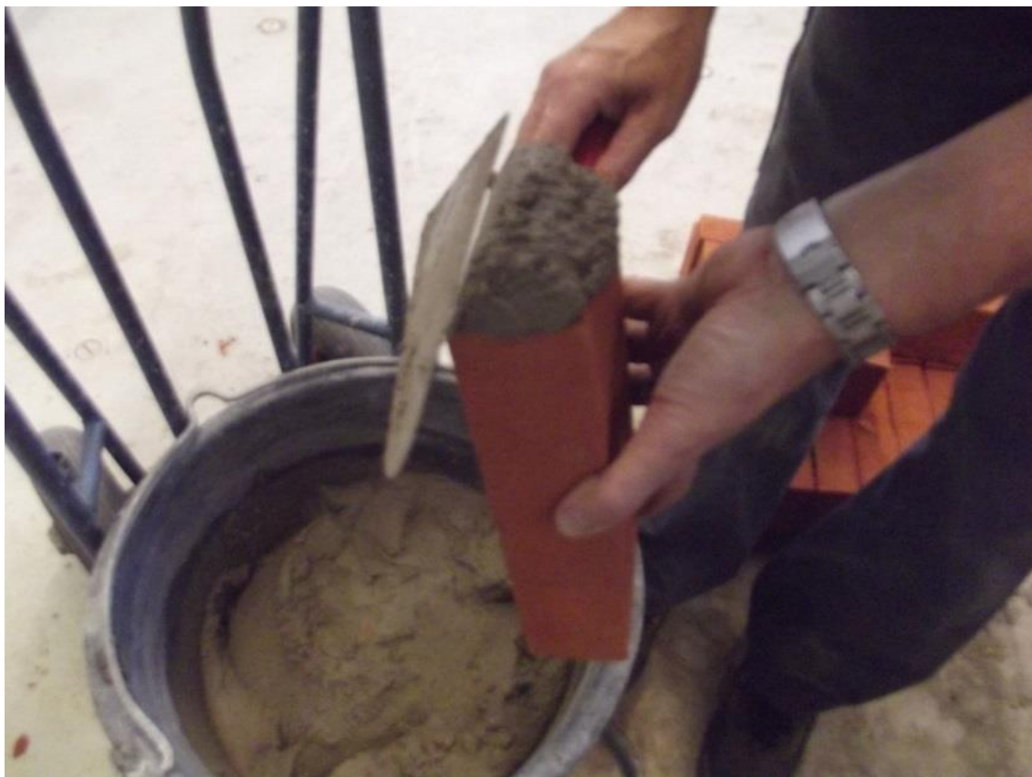
Figur 7.1. Studserne slås over hele kopenden ved opmuringen
