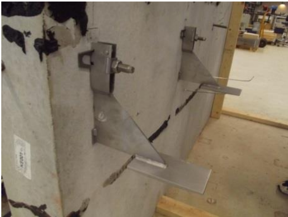
Figur 18.4. Glidekonsol med bevægelsesmulighed i alle retninger
