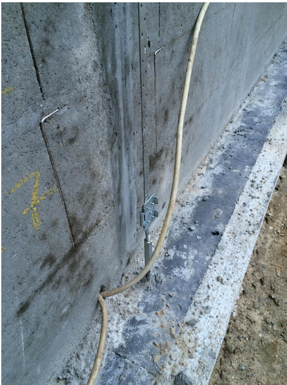
Figur 2.3. Opspændingsmekanisme til bånd
