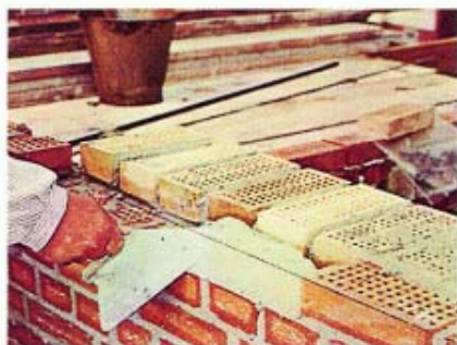
Mørtelen glattes ud mod forkanten
