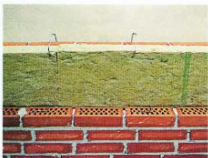
Sikring af isolering under ugunstige vejrforhold
