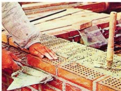
Løberen er trykket til snoren i flugt og lod, og mørtelpølsen er knebet
