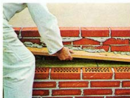
Fjernelse af mørtelpølser ved hjælp af spildbræt
