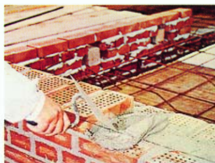
Mørtelen lægges og spaltes
