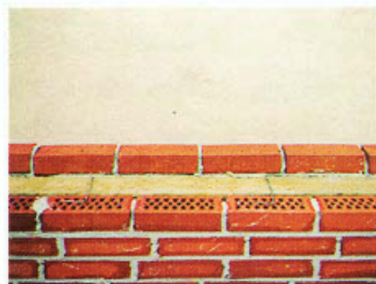
Første skifte bagmur i et trin opmuret
