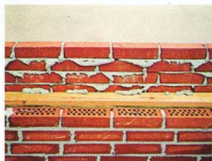
Opmuring tre skifter i bagmur
