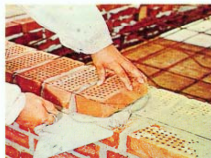
Stenen lægges, og mørtelen presses ud på skeen
