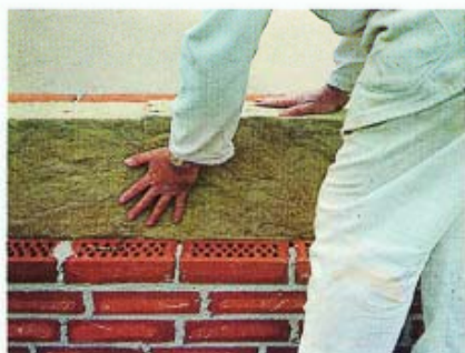
Isolering placeres
