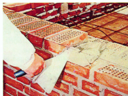
Mørtelen glattes, så den får en jævn, skrå flade ud mod forkanten
