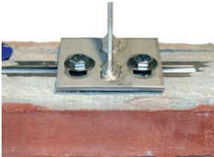
Figur 11.2.1 Ophængning i konsol, hvor bolte ikke er hårdt spændte (bevægelsesmulighed)
