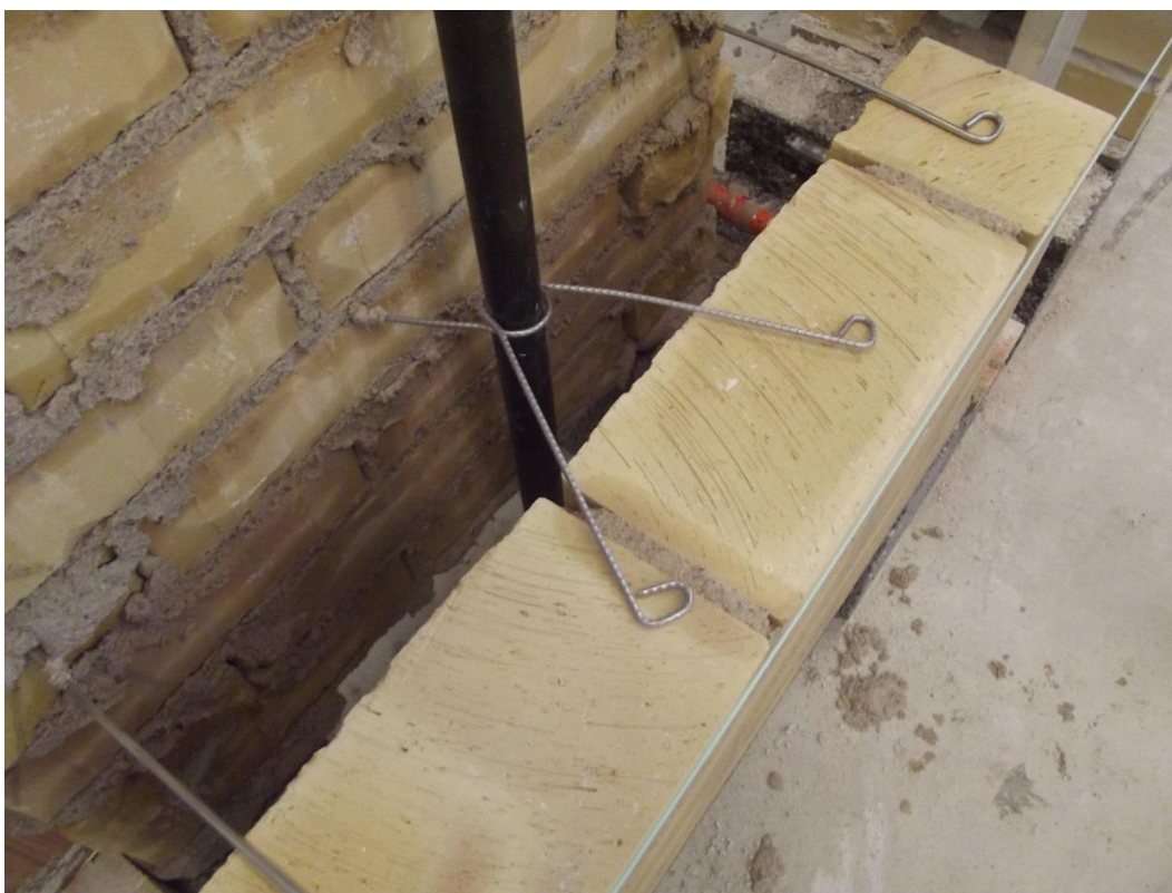
Fig. 3.8.2 Anvendelse af stabiliseringsbinder i praksis
