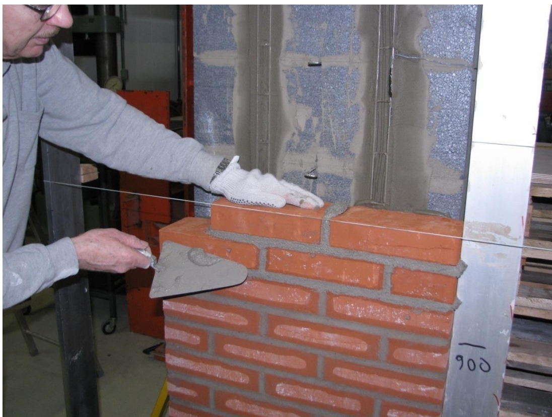
Foto 18. Formuren opføres, inden Multiklæb på EPS er hærdnet helt op.
