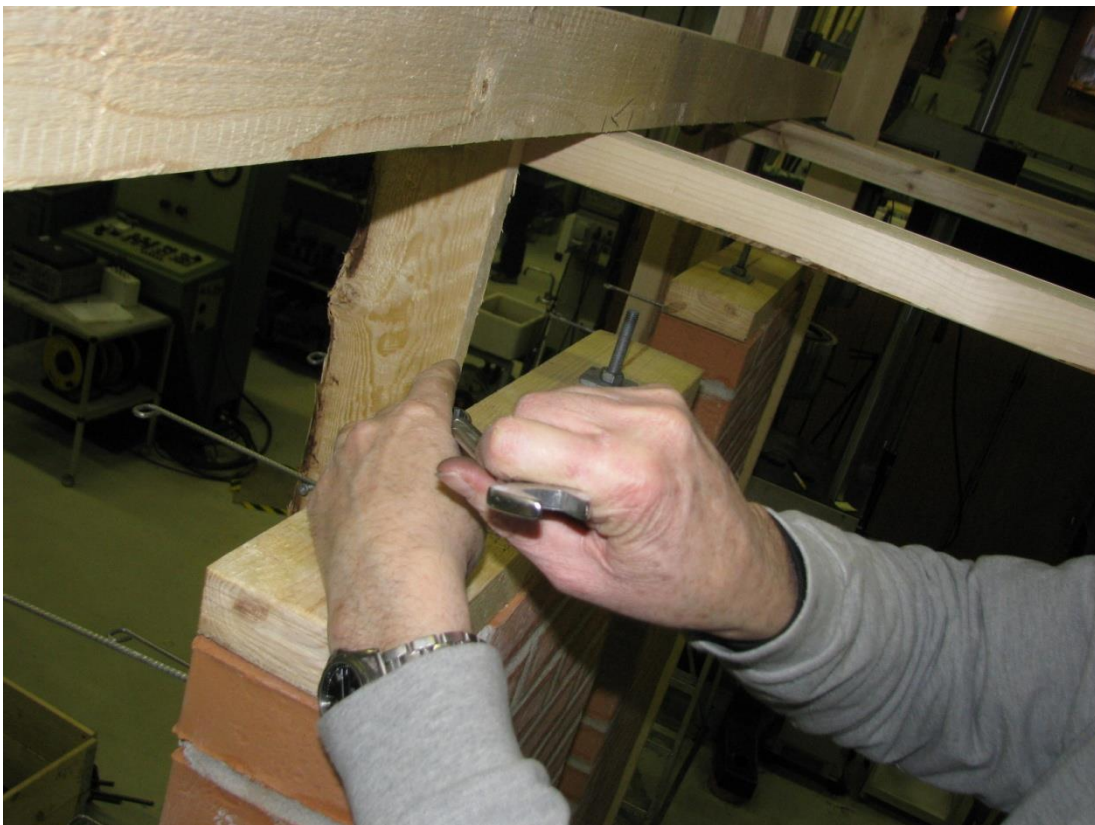
Foto 7. Rem monteres med spændeskive og møtrik.
