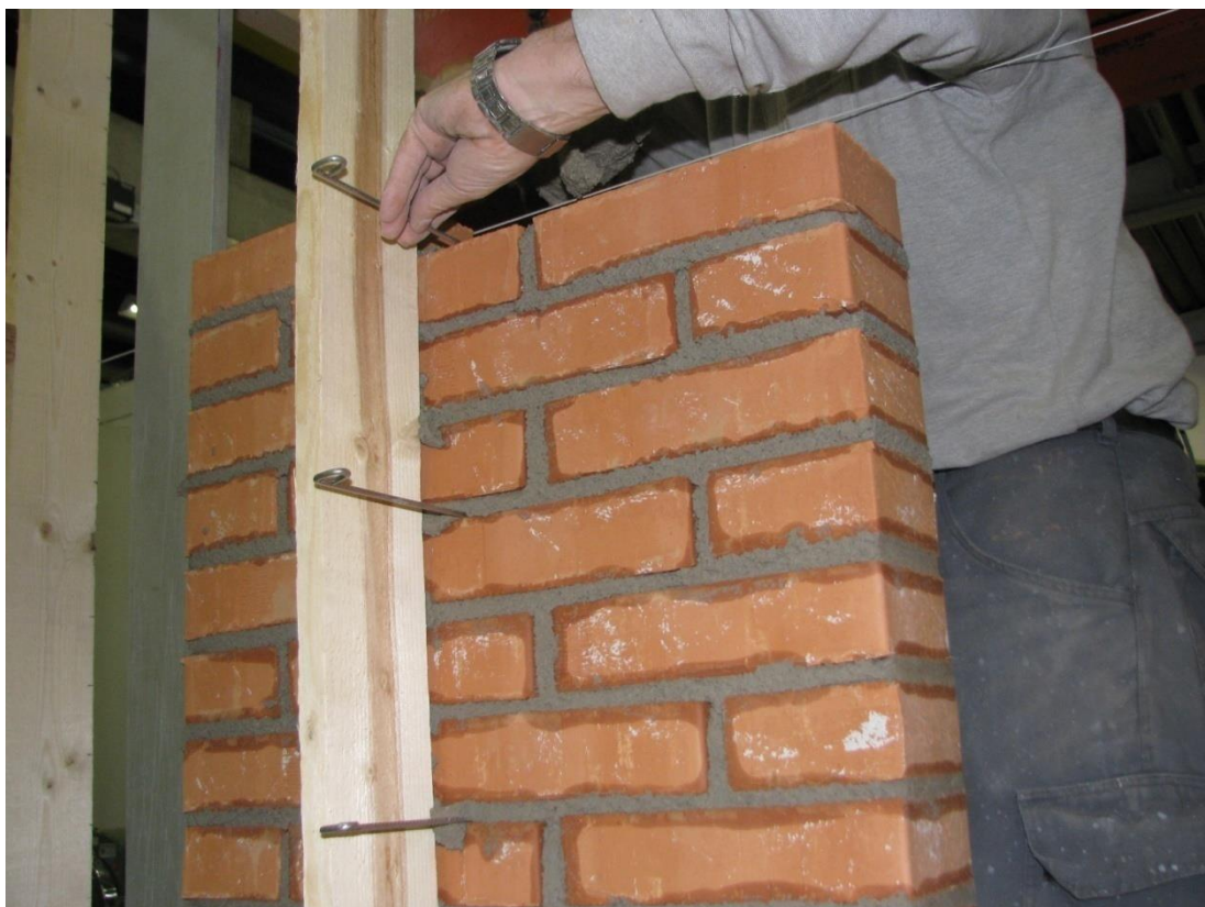
Foto 4. I den resterende del af væggen indsættes 1 binder pr 3. skifte. 1 binder gældende for en vægbredde op til 0,96 m eller 4 sten. Ellers 1 binder pr 0,96 m/4 sten.
