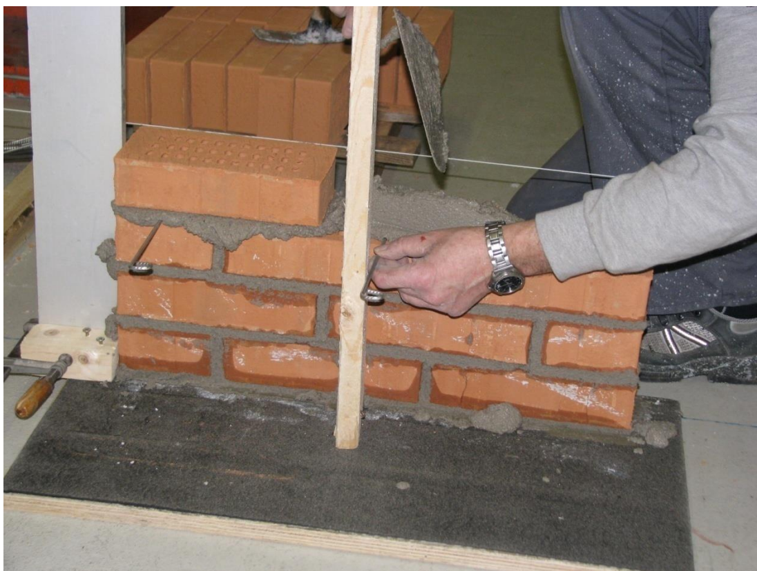
Foto 3. Ved bund og top indsættes 1 binder pr sten i 3. skifte fra bund og top. For den viste væg er dette 3 bindere i de aktuelle skifter.
