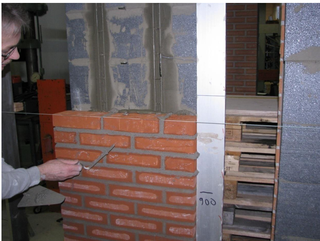
Foto 19. Fugerne skræbes og trykkes på sædvanlig vis efter opmuringen.
