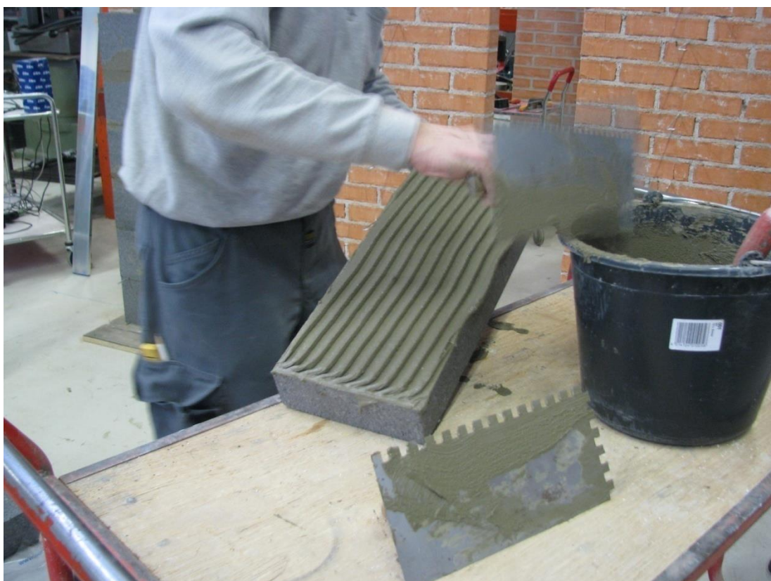
Foto 10. Påsmøring af Multiklæb
