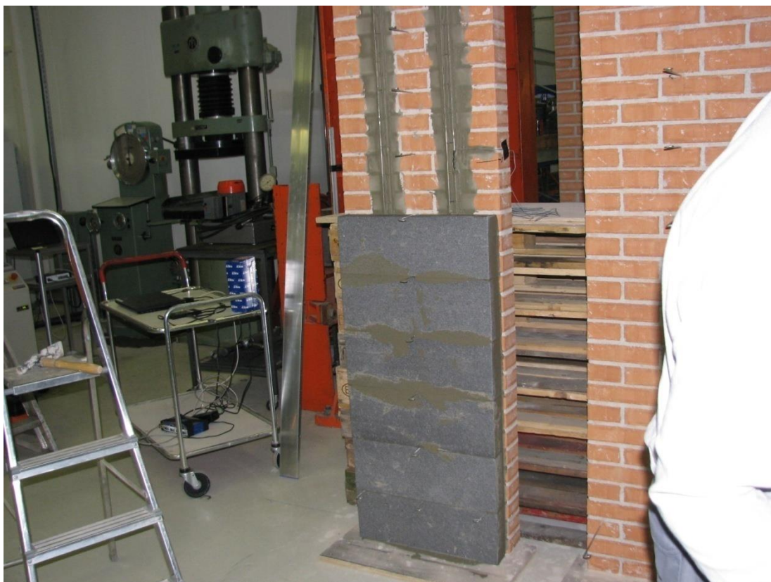
Foto 9. EPS-blokkene påsmøres lim i liggefuge og på bagside og trykkes mod bagvæg (vådt i vådt). Der anvendes tandspartel eller andet egnet værktøj. Ved hulrum > 6 mm anvendes tillige opmuringsmørtel. Max. hulrumstykkelser, hvor der anvendes lim-mørtel-lim er 20 mm.
