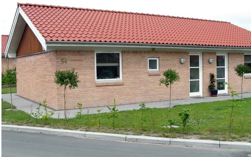
Figur 4 Byggeri 3 fremstår 2 år efter opførelsen uden misfarvninger.
