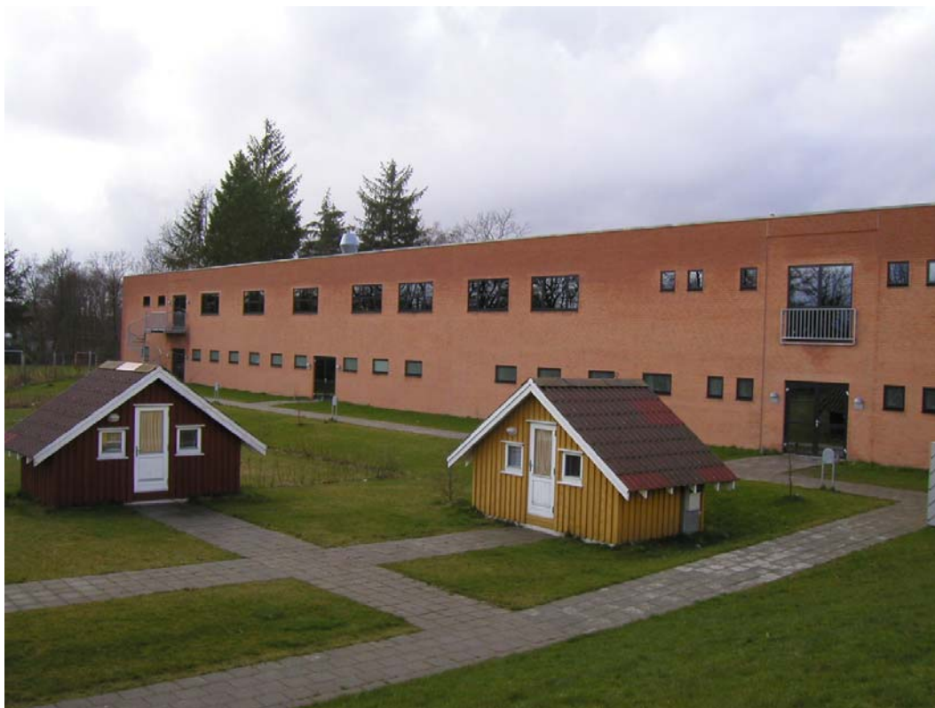
Figur 3 Byggeri 2 fremstår overordnet set uden markante misfarvninger 2 år efter opførelsen.
