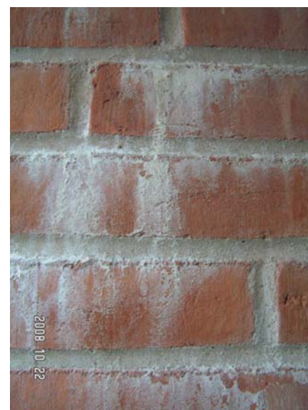
Figur 32. Byggeri 2. Seks år efter opførelsen. Ikke identisk med udsnit i figur 30 og 31, da misfarvningerne her var fjernet mekanisk.
