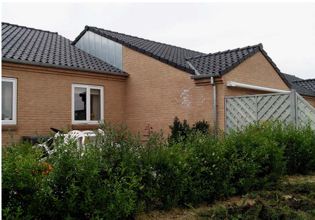
Figur 2 Byggeri 1. Murværk – 2 år efter opførelsen. Murværket har været udsat for normal vandbelastning under opførelsen. Den lyse misfarvning på gavlen skyldes en kombination af kraftig vandbelastning (overløb fra underdimensioneret tagrende) samt afsyring med for kraftig saltsyre (1 del saltsyre:3 dele vand).
