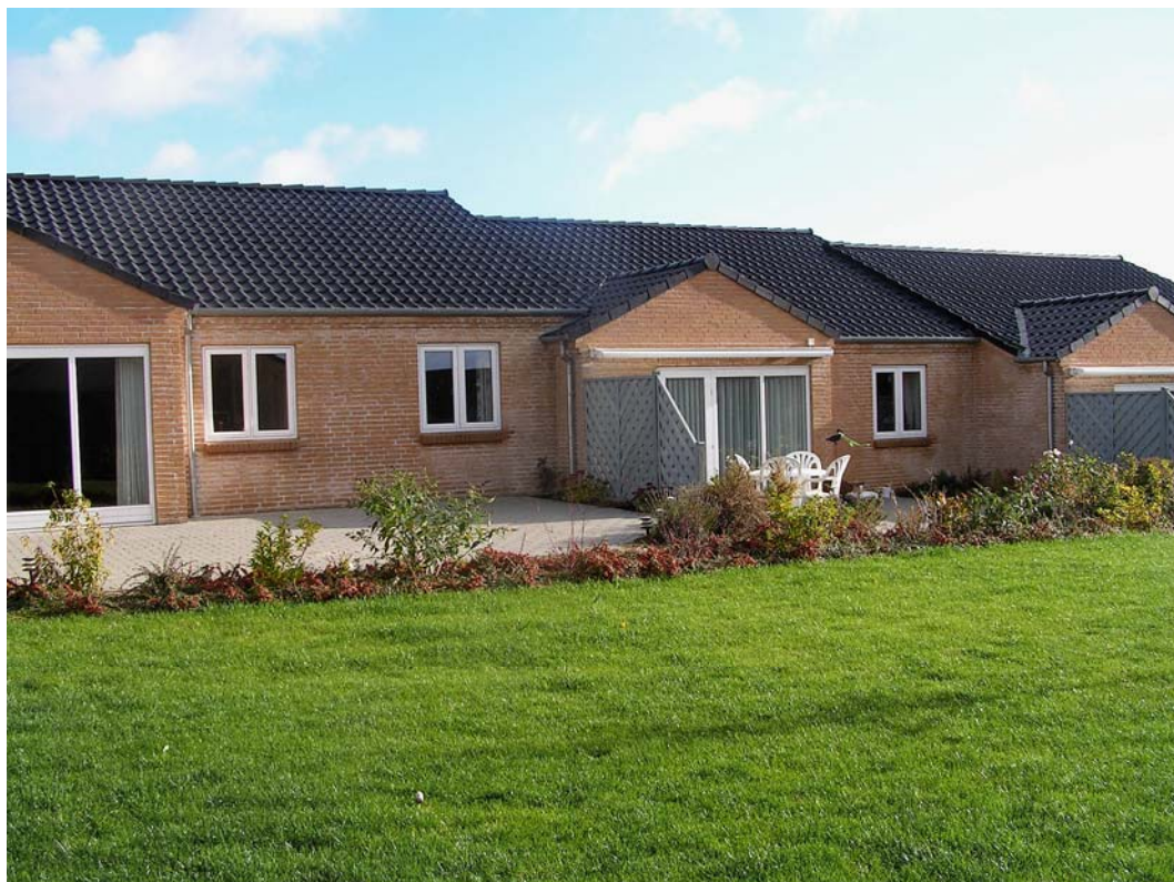
Figur 1 Byggeri 1. Murværk – 2 år efter opførelsen. Murværket har været udsat for ekstrem vandbelastning under opførelsen og fremstår med kraftige kalkudfældninger på fuger.
