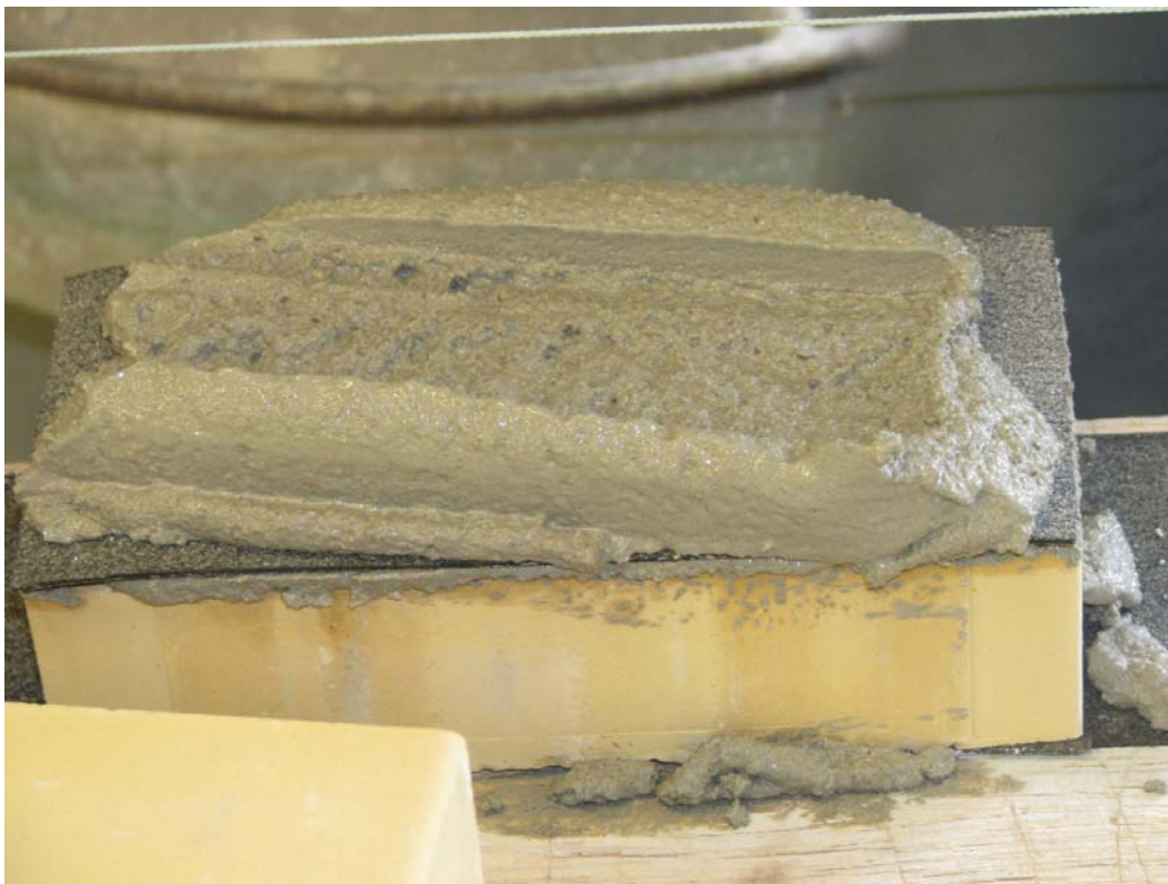
Foto 3. Ny mørtel lægges til cirka 6,0 mm fuge
