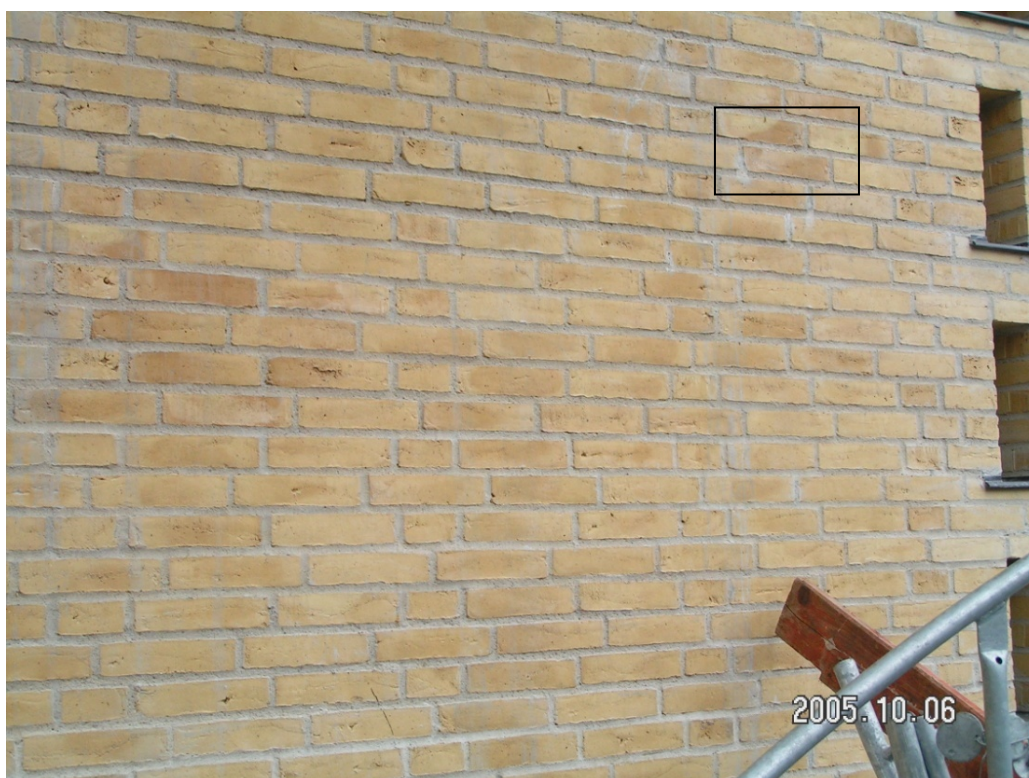
Figur 7. Sydfacaden, oktober 2005. 10 måneder efter opførelse. Der er kun få mørke sten tilbage.
