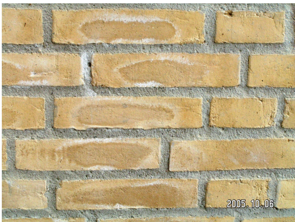
Figur 12. Overdækket østgavl, august 2005. 6 mdr. efter opførelse. Lokalt udsnit af Figur 10 og 11 (hvid firkant). Lyse og mørke misfarvninger af murværk.
