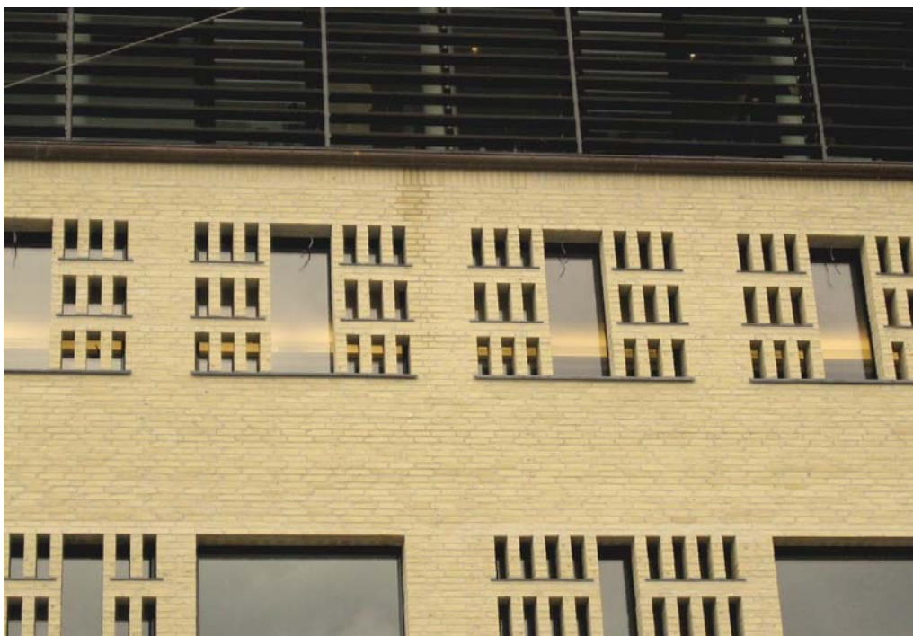
Figur 15. Nordfacade, august 2005. 6 mdr. efter opførelse. Øverst oppe umiddelbart under tagkonstruktionen, er den mørke misfarvning på murværk observeret.
