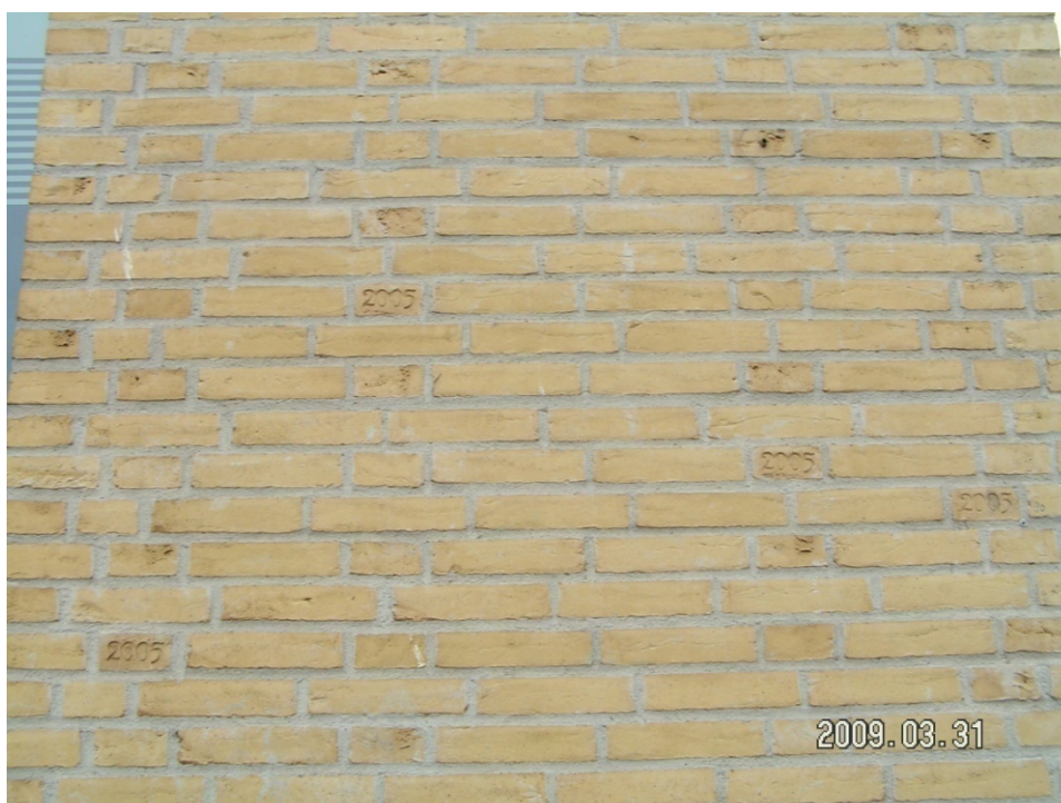
Figur 21. Nordfacaden, marts 2009. 4 år efter opførelse. Forekomsten af mørtel-slør på nord- og vestfacade er mindsket over de 4 år.
