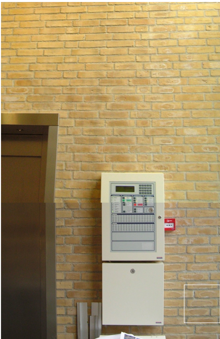
Figur 10. Overdækket østgavl, oktober 2005. 10 mdr. efter opførelse. Der er stadig stort set samme intensitet og udbredelse af mørke og lyse misfarvninger som i maj måned. Hvid firkant indkredser udsnit forstørret på de to efterfølgende billeder (Figur 12 og 13).
