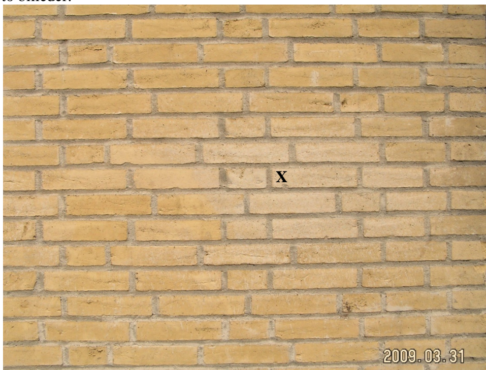
Figur 23. Vestgavl, marts 2009. 4 år efter opførelse. Mørtelresterne er reduceret i omfang i forhold til på figur 22. Der er mindst to sten, der har fået stenens egenfarve igen.
