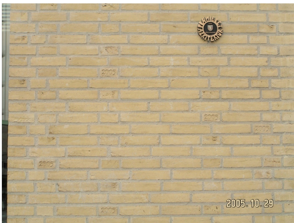
Figur 20. Nordfacaden, oktober 2005. 10 mdr. efter opførelse. Mørtelresterne er mindre synlige, når de observeres 3-5 m fra muren.
