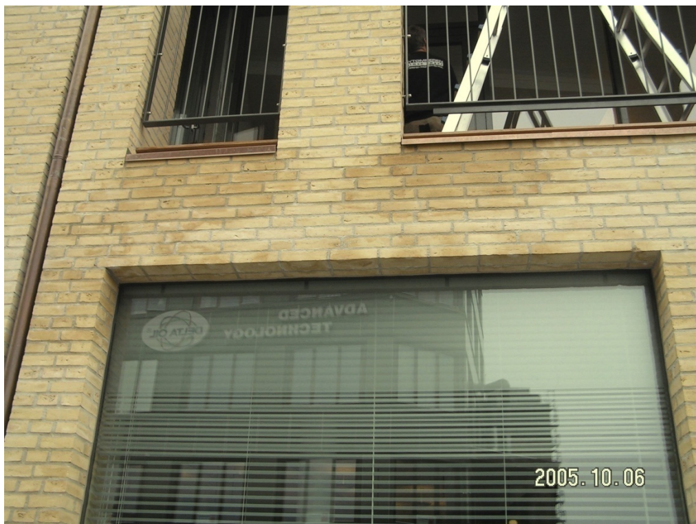
Figur 17. Vestgavl (mod M.P. Bruunsgade) oktober 2005. 10 mdr. efter opførelse. Mørk misfarvning på murværket som følge af nedsvivende vand fra kobbersålbænke i bunden af vinduespartierne.
