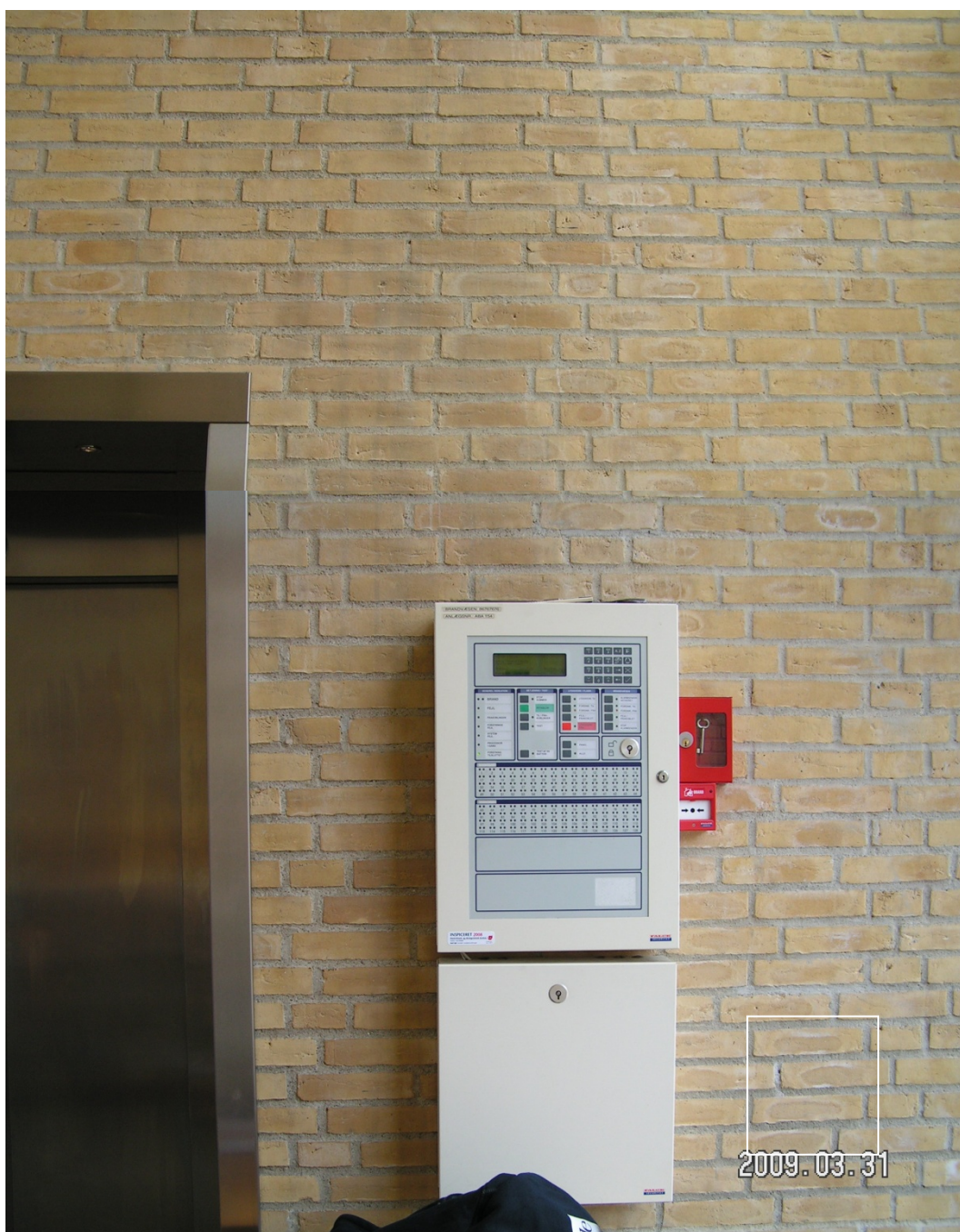
Figur 11. Overdækket østgavl, marts, 2009. 4 år efter opførelse. Intensiteten af de hvide misfarvninger på mursten er flere steder reduceret. Dette vurderes primært at være pga. kostning af muren.
