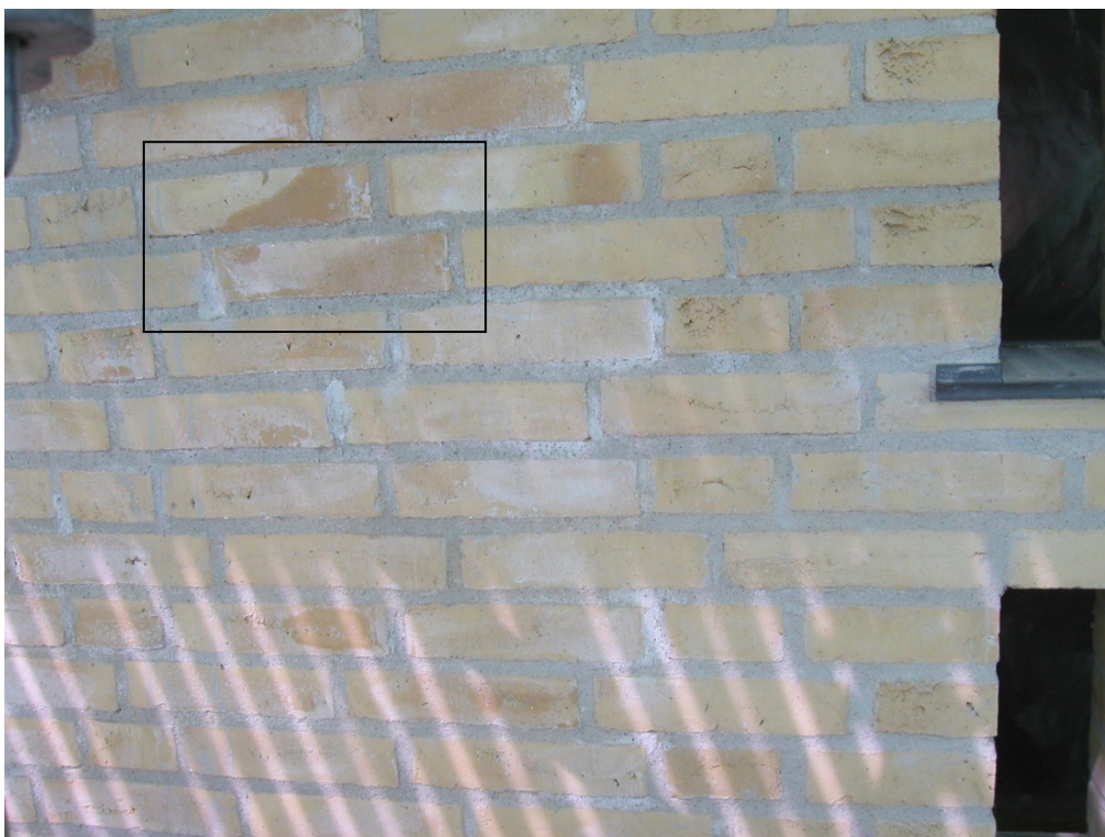
Figur 5. Sydfacaden, maj 2005. 3 mdr efter opførelse. Mørke misfarvninger på murfeltet er aftaget kraftigt i henhold til figur 4. Lyse misfarvninger har delvist erstattet de mørke misfarvninger. Nogle af de grålige misfarvninger skyldes mørtelrester.
