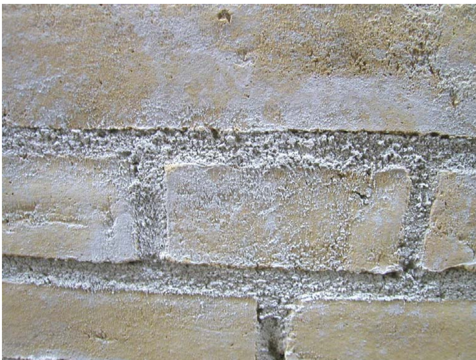
Figur 19. Eksempel på udsnit af nordfacaden, oktober 2005. 10 mdr. efter opførelse. Mørtelresterne ses tydeligt på kort afstand, mindre end 0,5 m fra muren.
