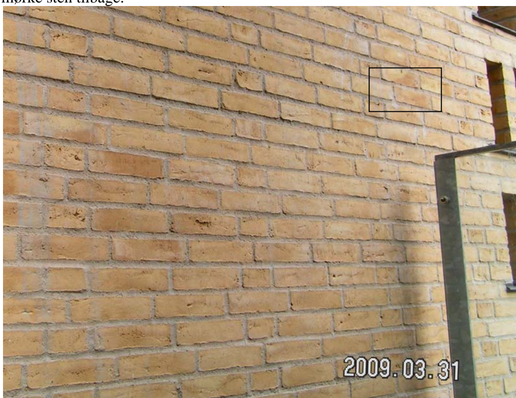
Figur 8. Sydfacaden, marts 2009, 4 år efter opførelse. Stenene har stadig den karakteristiske mørkfarvning som efter ½ år. Set i et længere perspektiv er misfarvningerne kraftigt reducerede og de tilbageværende mørkfarvninger ser ud til at indgå som naturlige farvenuancer.
