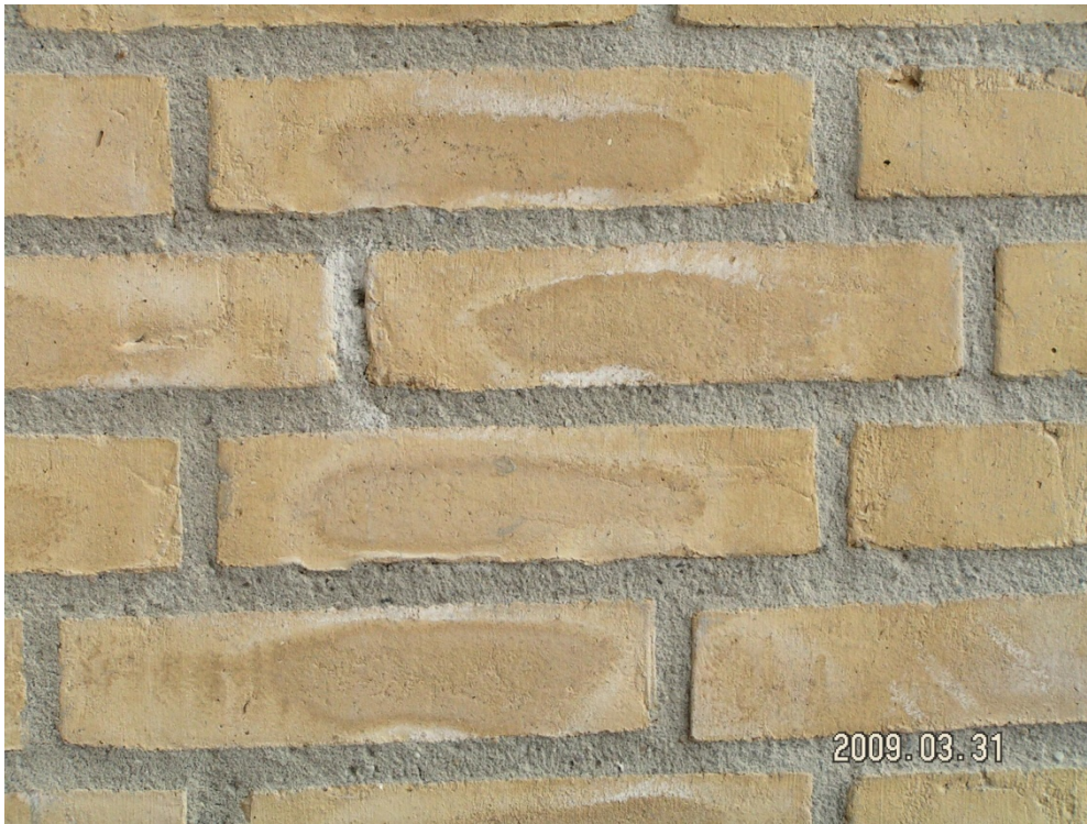
Figur 14. Overdækket østgavl, marts 2009. 4 år efter opførelse. Samme udsnit som figur 12 og 13. Her ses det tydeligt at dele af de hvide misfarvninger er fjernet med kost.
