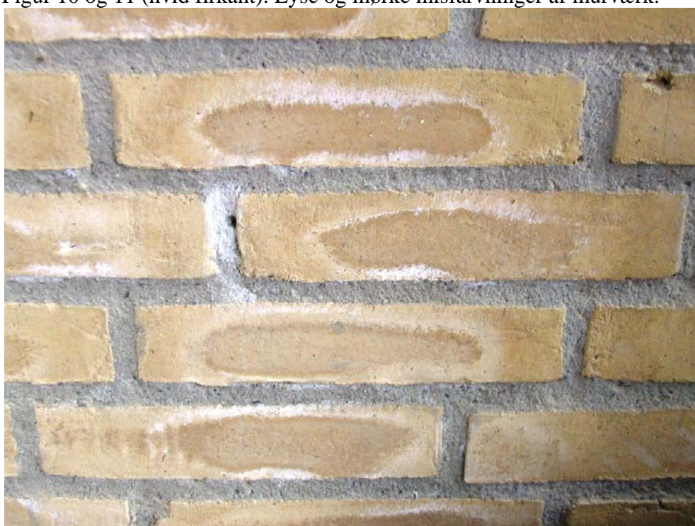
Figur 13. Overdækket østgavl, oktober 2005. 10 mdr. efter opførelse. Samme udsnit som på Figur 12, der viser at de lyse og mørke misfarvninger ikke har ændret sig væsentligt siden august.
