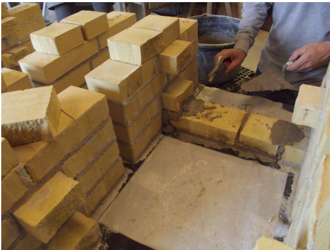
Foto 12. Prøvelegeme B. Stående fortanding u. bindere. Opmuring fortsættes efter ca. 1 uge. Fugeske anvendes ved stående fortanding
