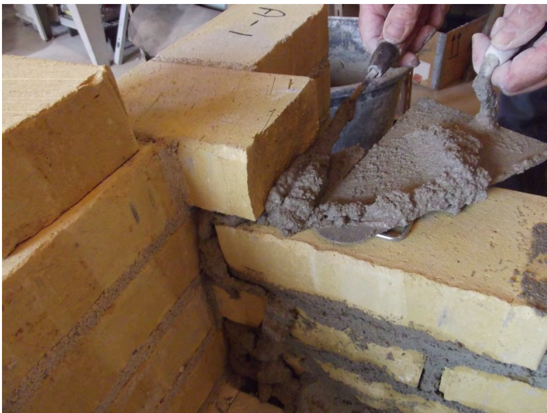
Foto 11. Prøvelegeme A. Stående fortanding m. bindere. Fugeske anvendes ved stående fortanding
