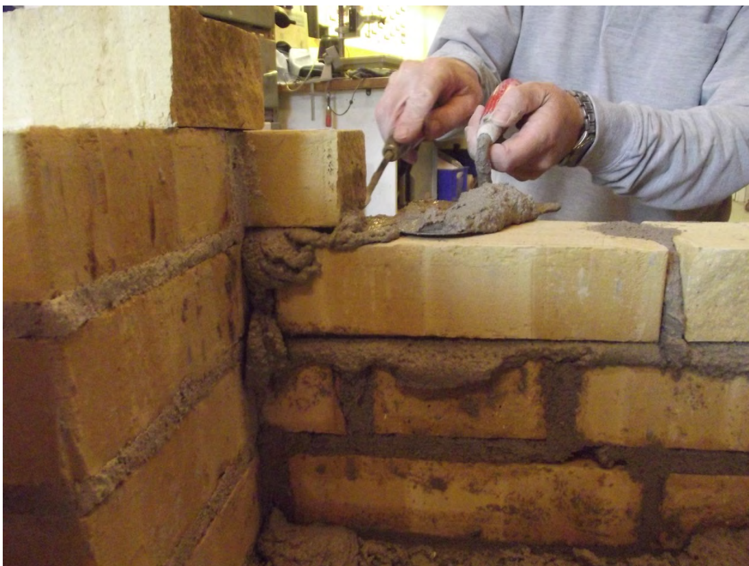
Foto 13. Prøvelegeme B. Stående fortanding u. bindere. Opmuring fortsættes efter ca. 1 uge. Fugeske anvendes ved stående fortanding
