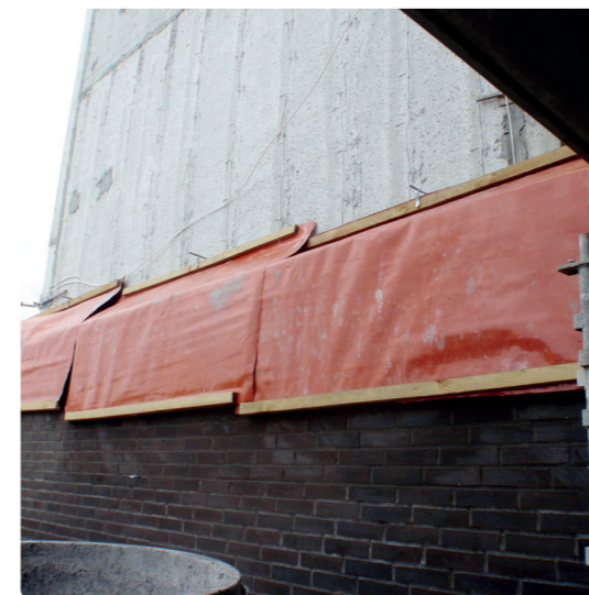
Afdækningen skal være tætsluttende ind mod en allerede opført bagmur, således at regnvand ikke ledes ned i isoleringen.
