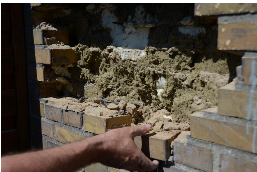
Fig. 7: Destruktive undersøgelser for at klarlægge tilstand og konstruktionsdetaljer
