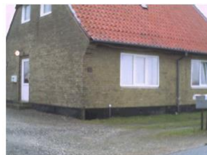
Figur 30: Ålkærvej 19 - sydfacade – markante kuldebroer rundt om vinduer samt ved fundament.
