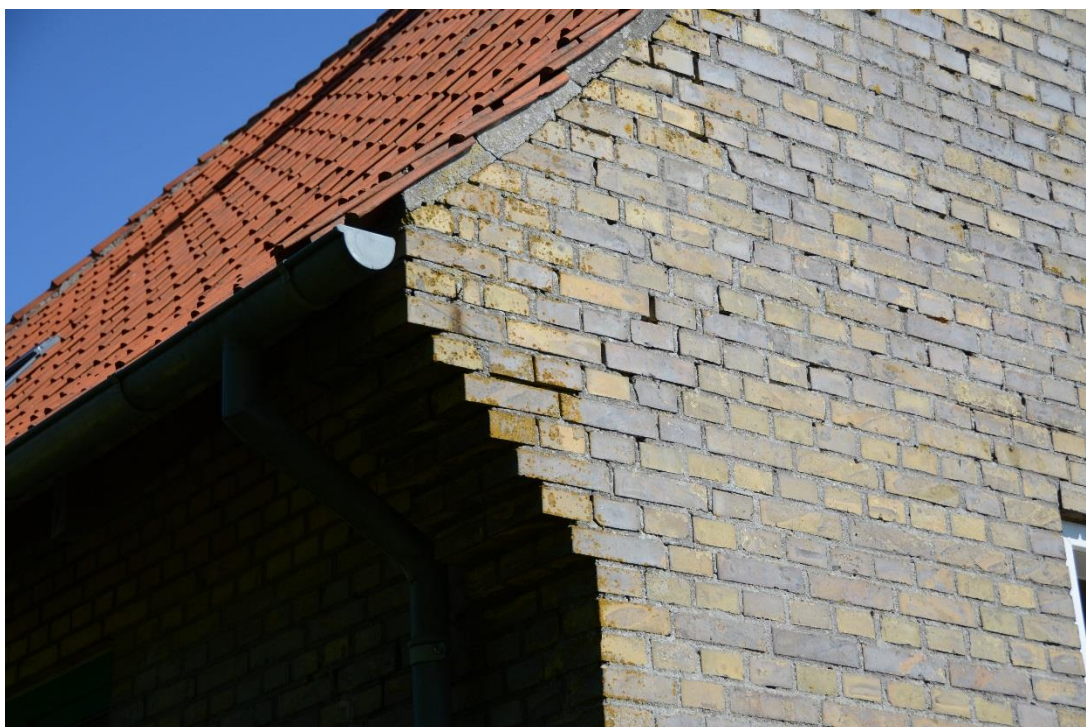
Fig. 3: Udmuring ved hjørne og tydelig fugeforvitring
