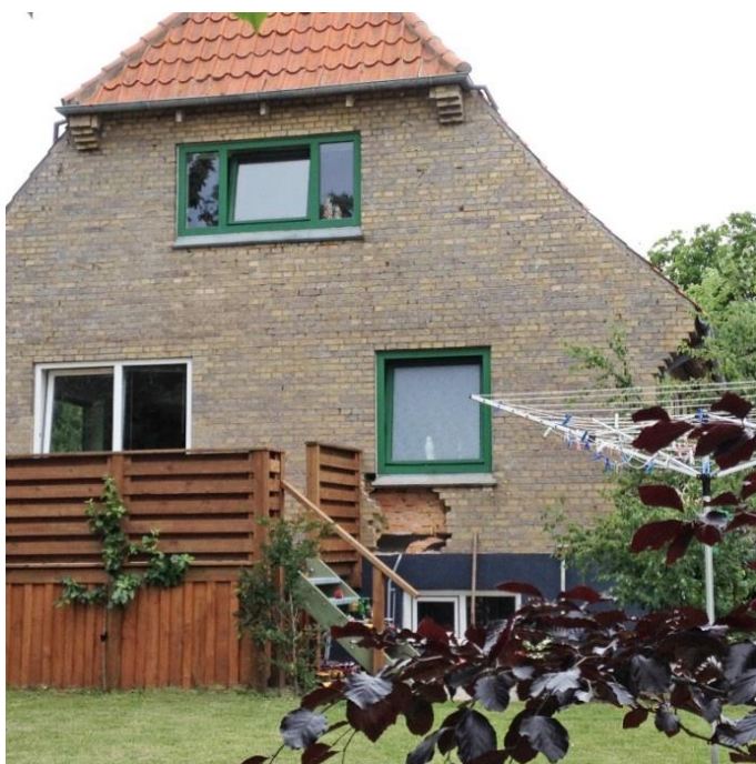
Fig. 2: Som en del af forundersøgelsen udtages et murfelt
