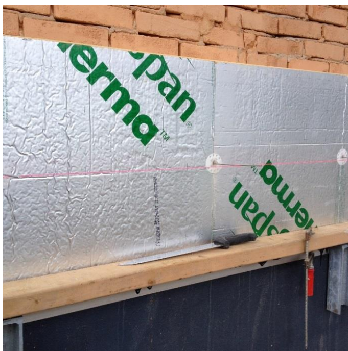
Fig. 24: Isolering opstartet – der monteres efter snor for både skiftegang og tykkelse
