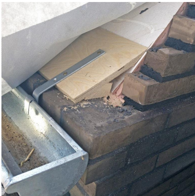
Fig. 38: Ny fodplade og rendejern klar til tagfod og folieoverlæg
