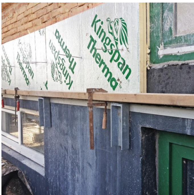
Fig. 23: 1. lag isolering monteret med bindere. Der er midlertidigt fastgjort en reglar ved sokkelskinne for at lette monteringen af første række af de hårde isoleringsplader
