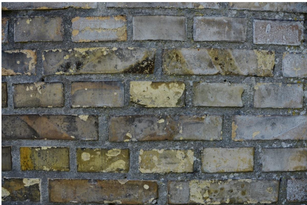
Fig. 4: Afskalninger fra sten
