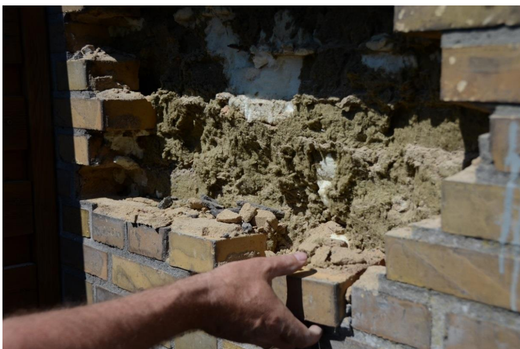
Fig. 5: Udtagelse af sten i formur, bagved ses forskellige isoleringsmaterialer
