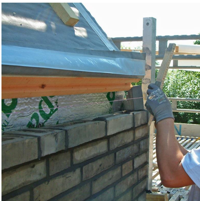
Fig. 37: Mens der mures gesims, holdes undertag oppe. Overskydende tagisolering skæres bort
