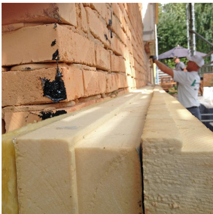
Fig. 12: Kingspan pladeisolering med folieforside og 30 mm blød mineraluldsisolering på bagsiden for optagelse af ujævnheder i bagmuren
