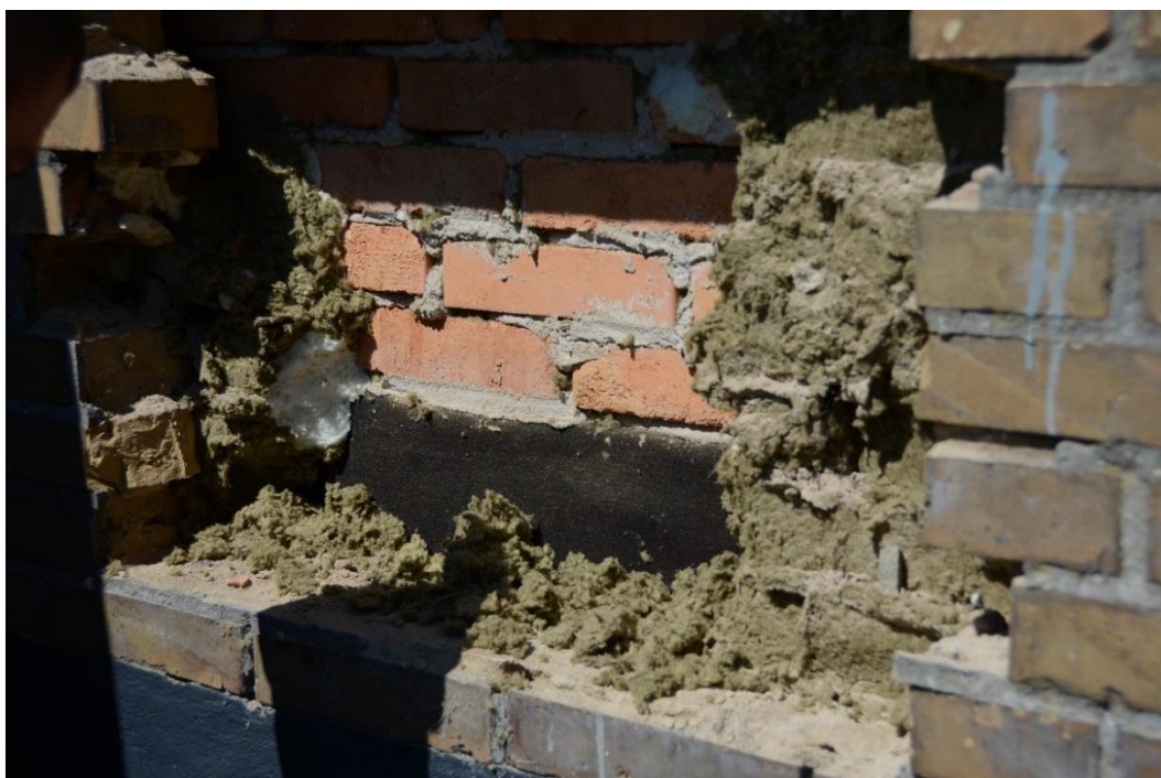
Fig. 6: Murpap og bagmur af molersten blotlagt
