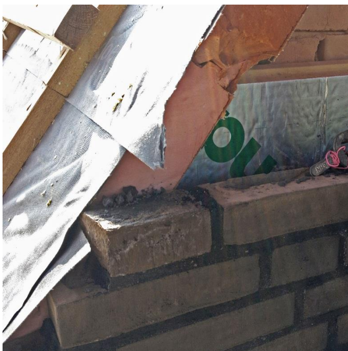
Fig. 26: Isolering i facade og tag mødes, så kuldebroer undgås
