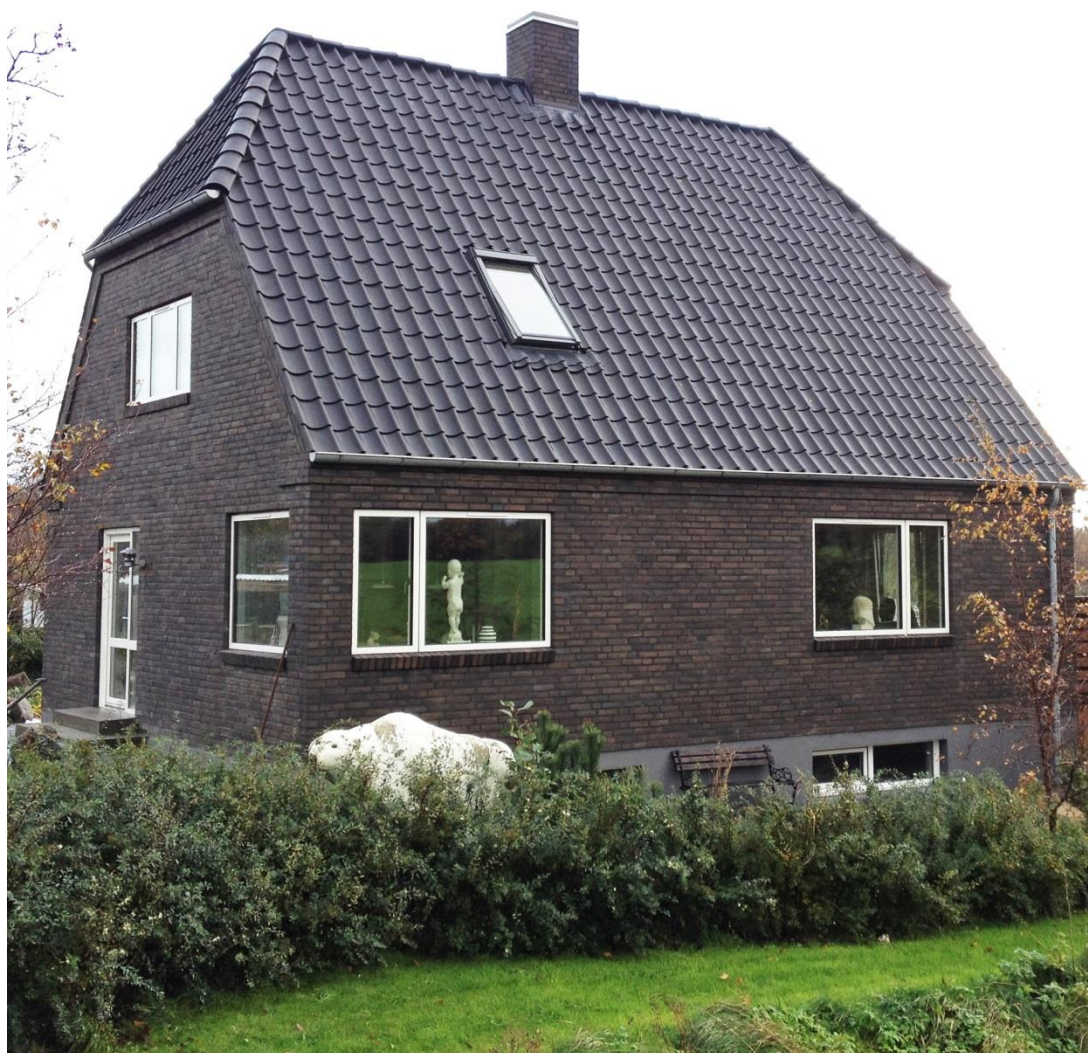
Fig. 37: Det færdige hus med nyt udtryk
