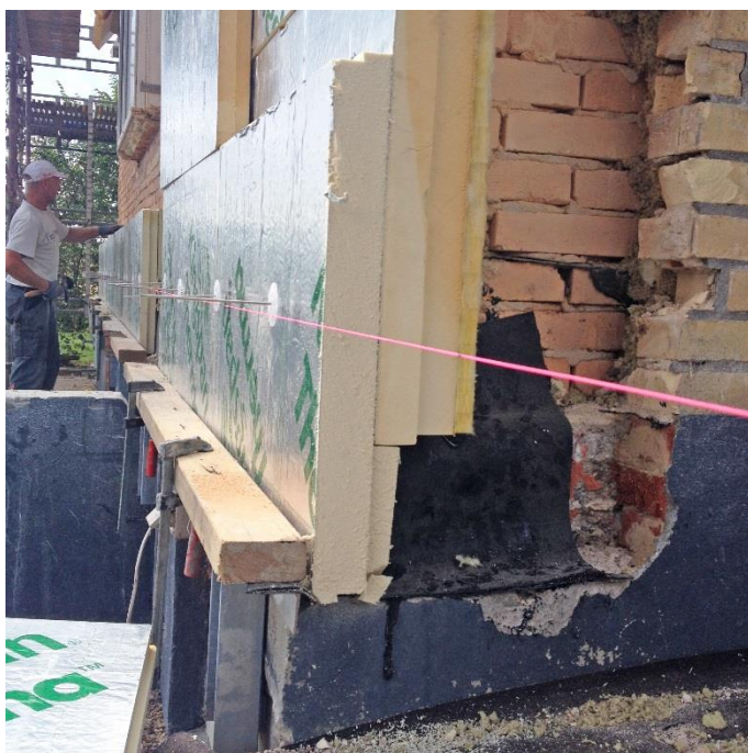
Fig. 20: Vandfalspap bag ny isolering på facaden og ført om hjørnet til gavlen, hvor den eksisterende formur endnu ikke er nedrevet
