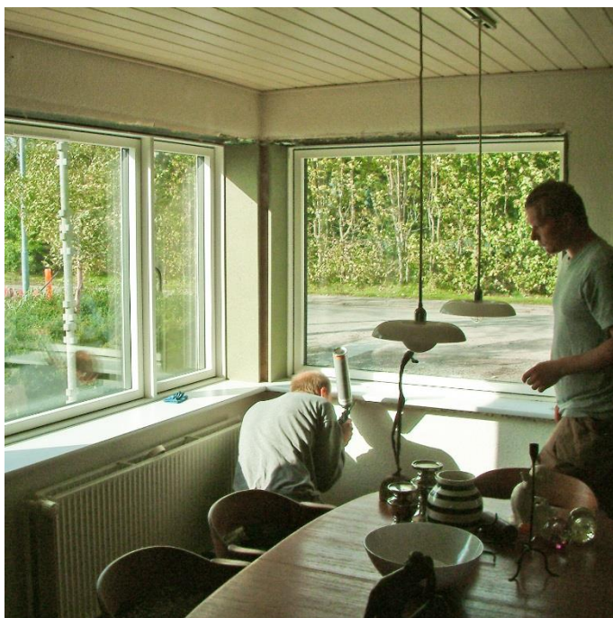
Fig. 31: Da vinduerne er rykket frem, udføres nye lysninger
