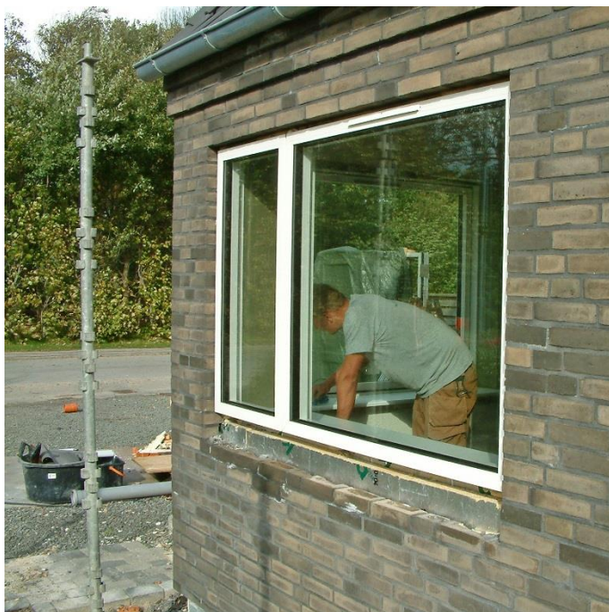
Fig. 30: Vinduer monteret – nye lysninger færdiggøres
