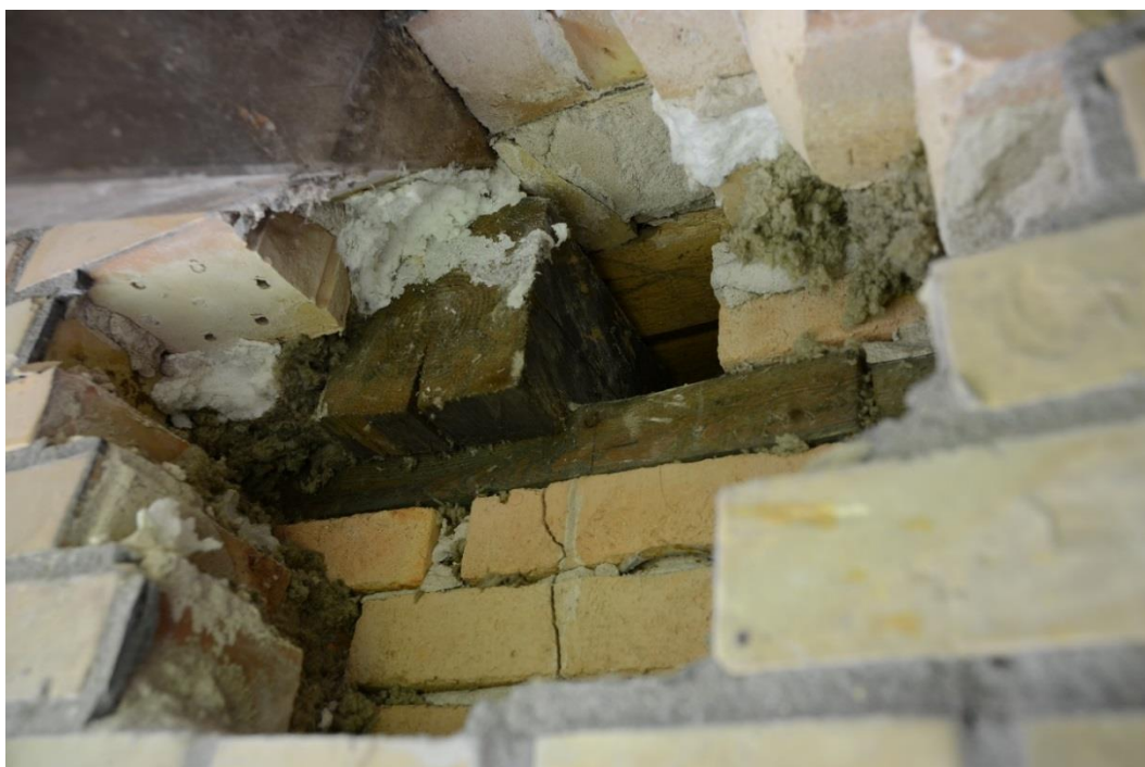
Fig. 8: Bjælke og murrem blotlagt mod vest
