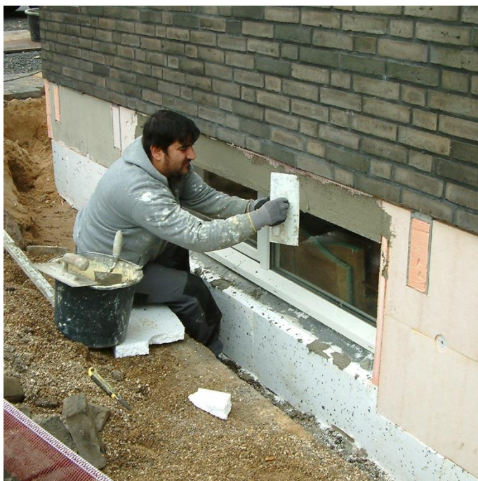
Fig. 33: Sokkel med ny isolering pudses
