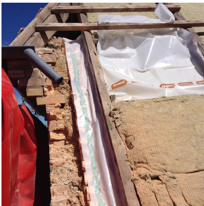
Fig. 35: Dampspærre monteres tæt til bagmur og sikrer lufttæthed i tagkonstruktionen
