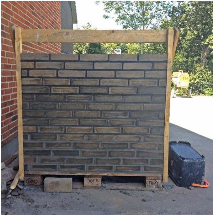
Fig. 10: Fugefarve har afgørende betydning for facadeudtrykket – kun fugefarven varierer i prøvemuren!
