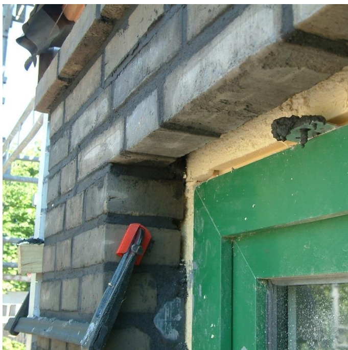
Fig. 27: Sidefalse muret med skårne vinkelsten forsynet med inserts til montering af nye vinduer.
