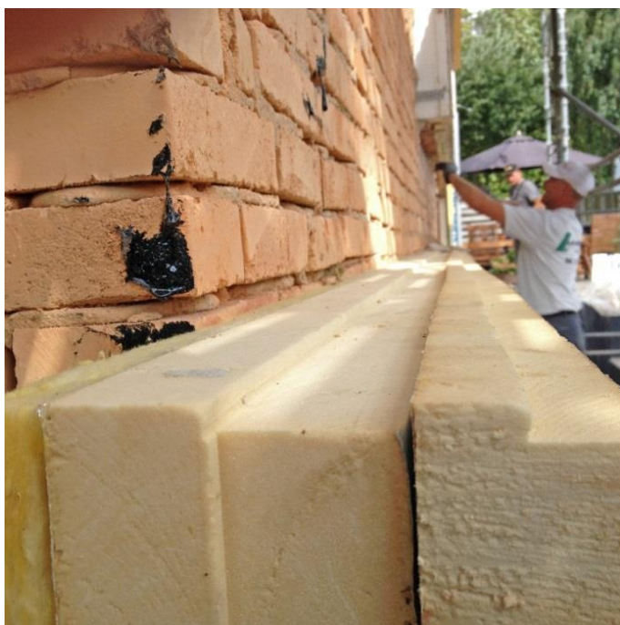
Fig. 25: Inderst ses blød isolering til optagelse af ujævnheder i bagmur
