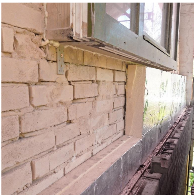
Fig. 16: Gavlvindue midlertidigt fastgjort til bagmur med vinkelbeslag
