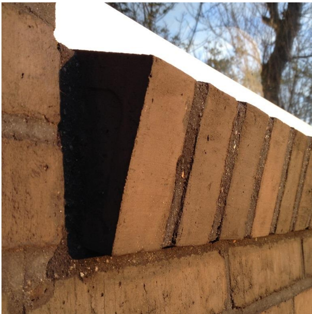
Fig. 29: Klassiske murede løsninger er mulige i konceptet – her muret sålbænk
