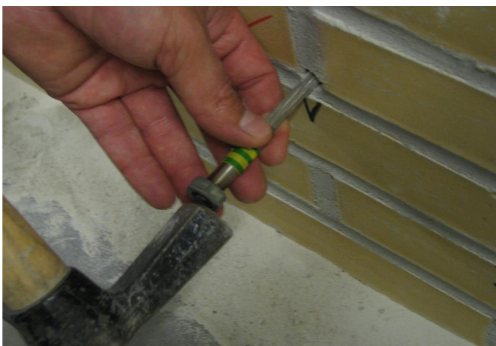
Figur 4. Krydsbor bankes normalt 20-30 mm ind i fugen.
