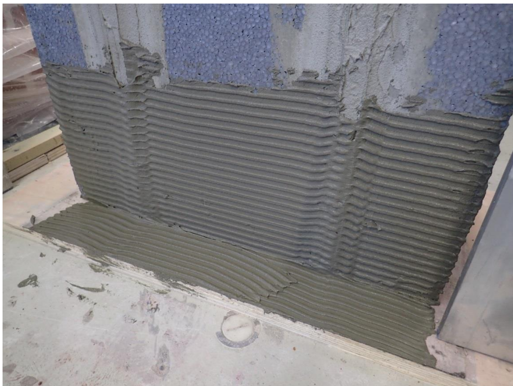
Foto 11. Den yderste skal forberedes med et lag multiklæb oven på EPS-pladen og Murtec Distæn.
