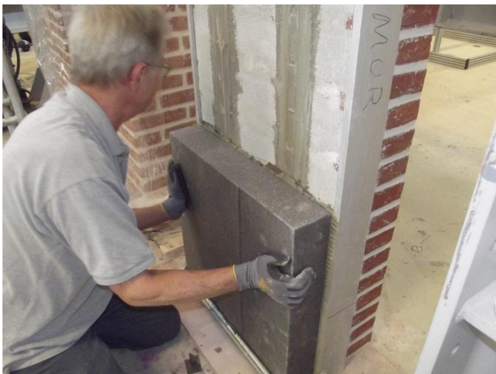
Foto 8. EPS-pladen presses imod bagmuren.
