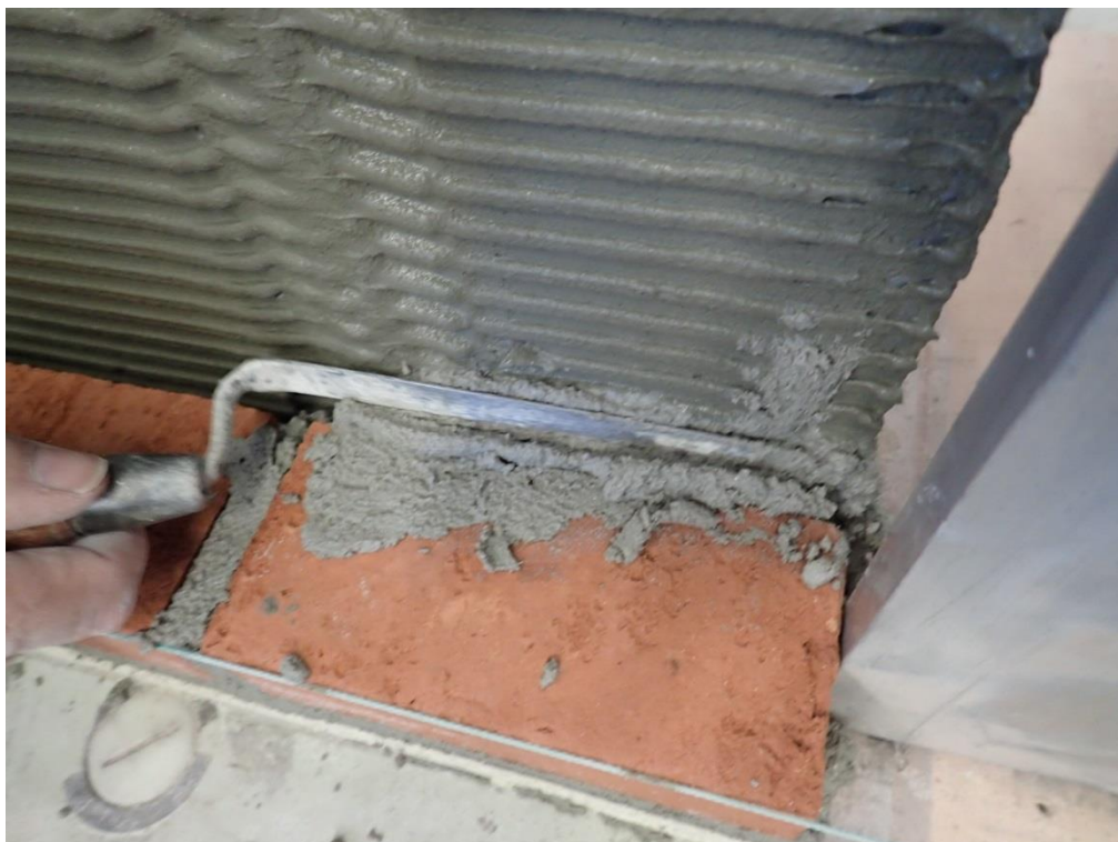
Foto 13. Der fyldes med mørtel i hulrummet imellem multiklæb og mursten. Mørtlen skal presses ned og hulrummet fyldes godt ud.
