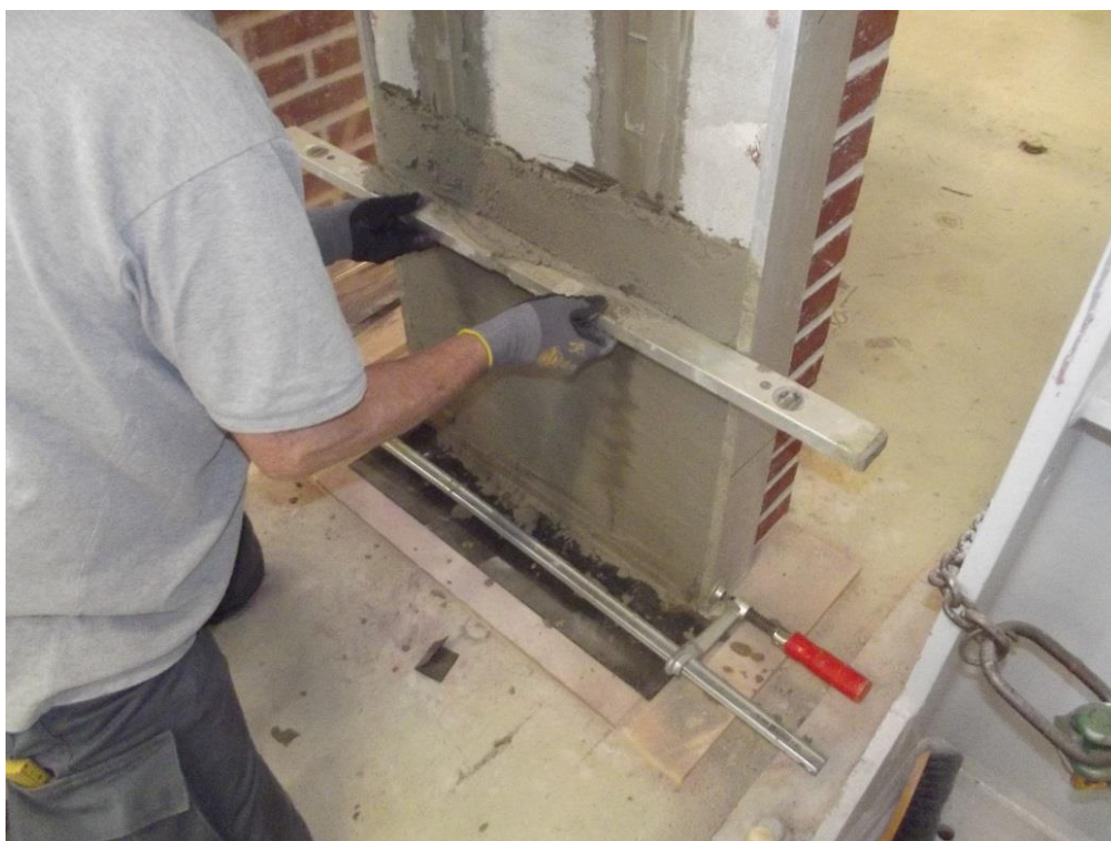
Foto 6. Bemærk at på fotoet ses aluminiumsplader i siderne af EPS-søjlen, som hjælper med at kontrollere dybden af mørtellaget samt ift. afretningen.
