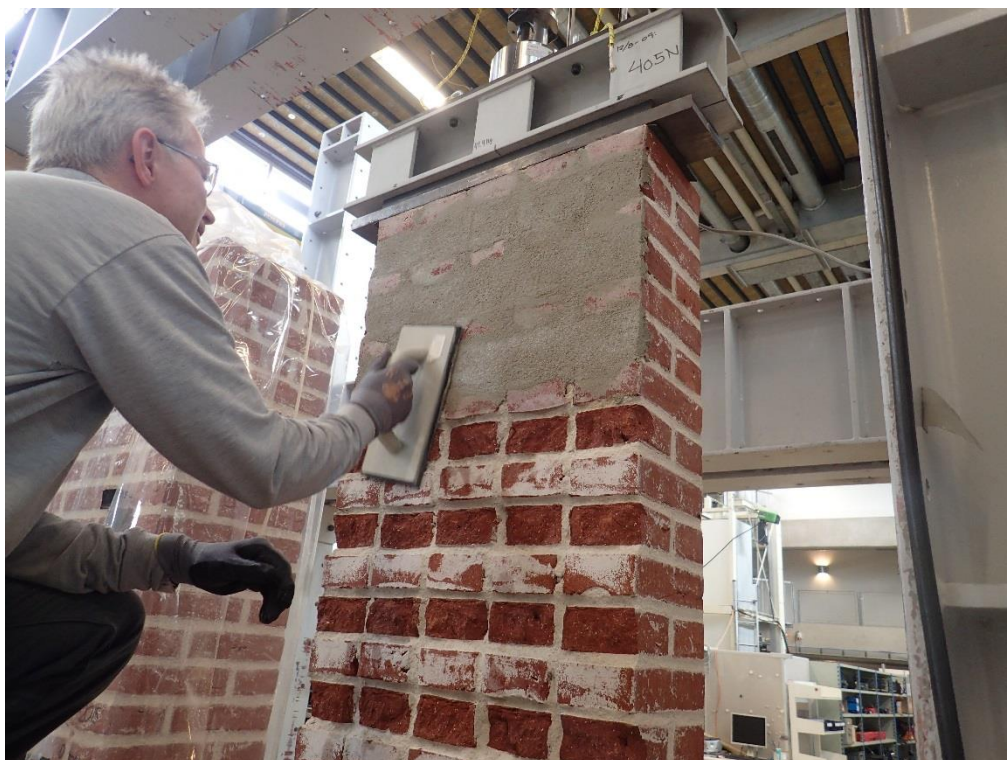
Foto 2. Udjævning af bagmur med multiklæb. Udjævningen hærdner i et par dage, før det videre arbejde fortsættes.
