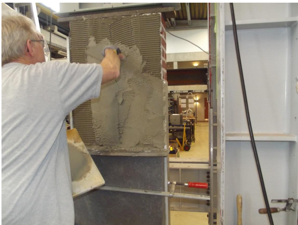
Foto 9. Samme arbejdsgang fortsættes opad. Husk at påføre multiklæb imellem EPS-pladerne også.
