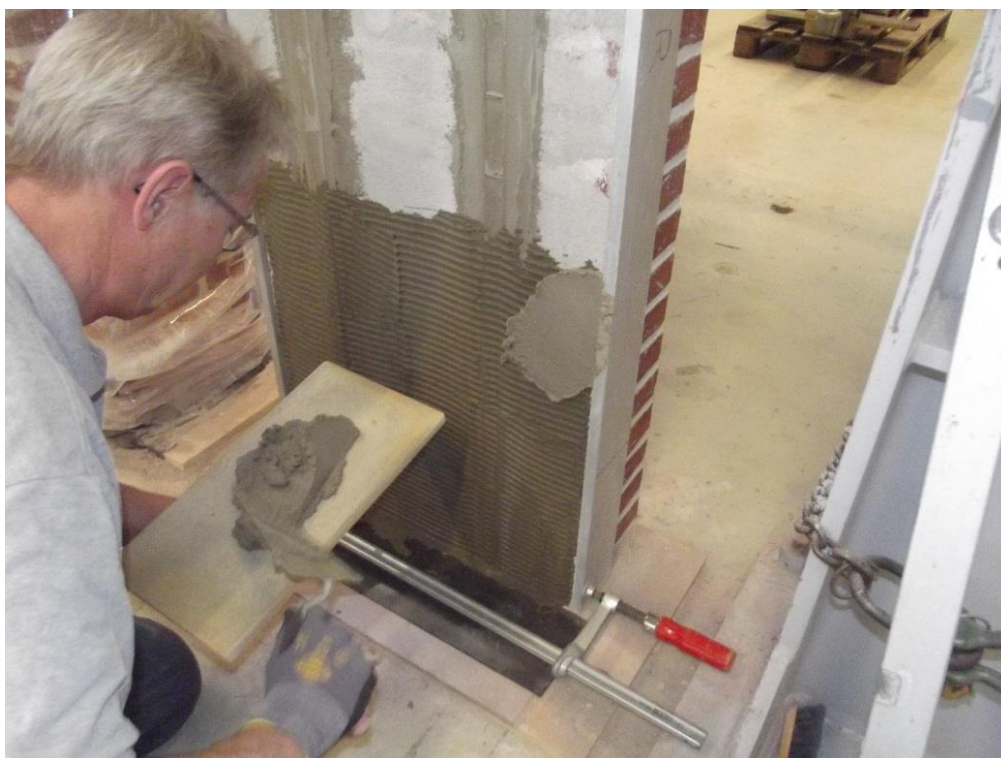
Foto 5. Der påføres et ca. 12 mm lag muremørtel oven på det våde uhærdnede lag multiklæb. Der kan anvendes samme mørteltype, som anvendes til opmuringen af den nye ydre skal, fx KC 50/50/700 tørmørtel eller stærkere.
