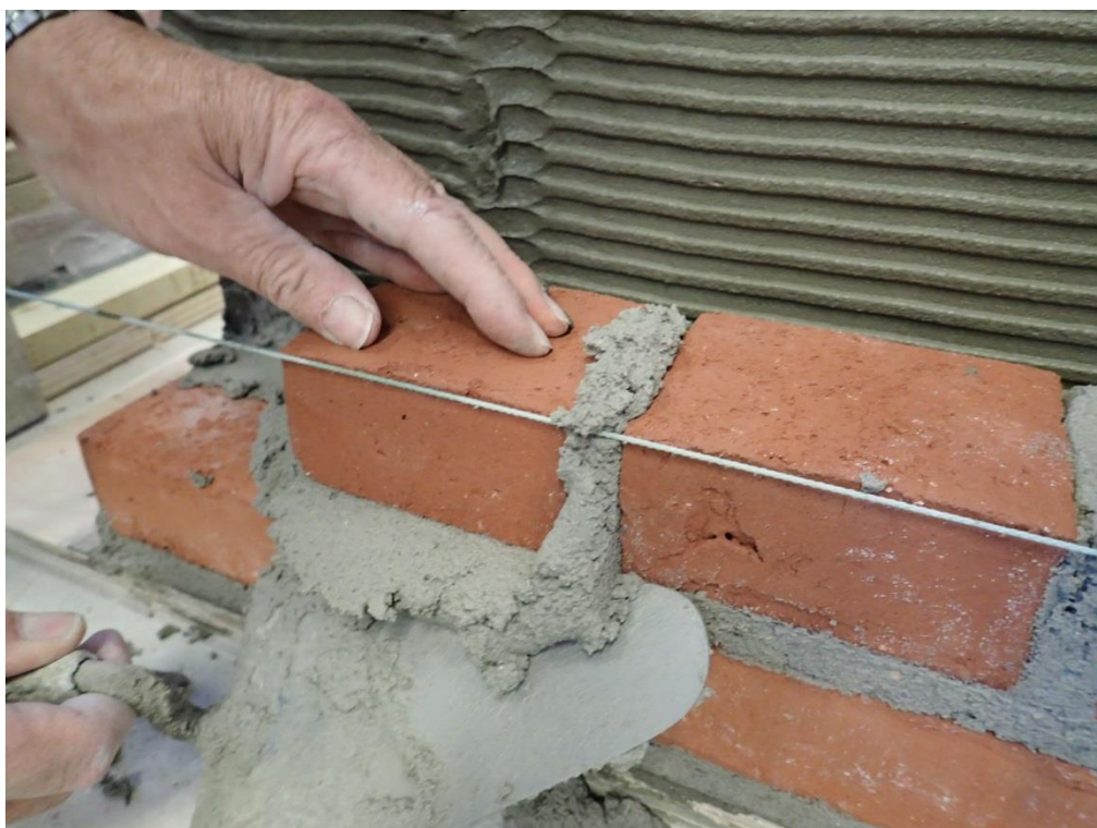
Foto 14. Det er væsentligt at konstruktionen udføres som en sammenhængende konstruktion med samme høje fyldningsgrader i studsfigurerne som ved almindeligt murværk.
