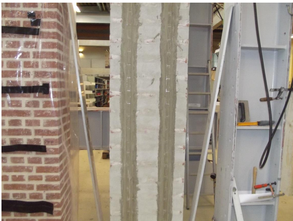
Foto 3. Efter udjævningen er hærdet, pålimes 2 kolonner af Murtec Dista i multiklæb.
