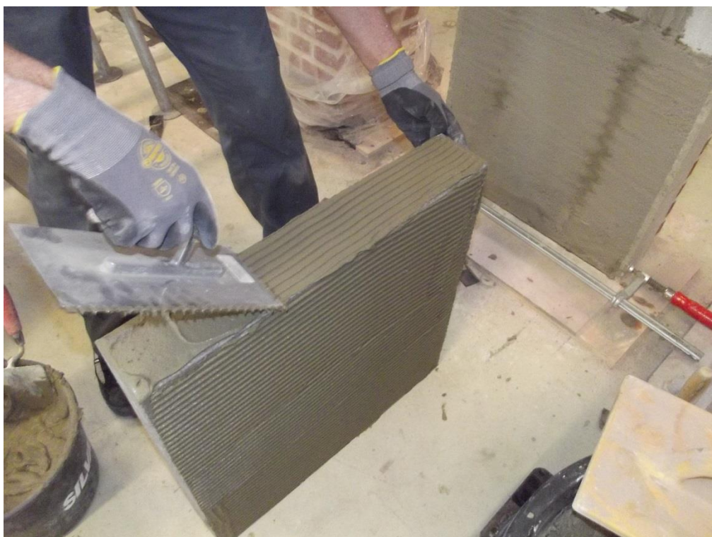
Foto 7. En 600 x 600mm EPS-plade gøres klar ved at påføre multiklæb på den store flade, som vil blive presset imod bagmuren samt multiklæb i bund.
