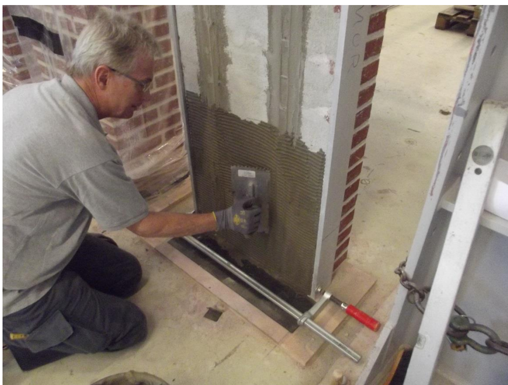
Foto 4. Der påføres et nyt lag multiklæb oven på Murtec Dista ved brug af en 5 mm tandspartel. Dette lag påføres horisontalt og laget påføres i hele EPS-søjle's højde.
