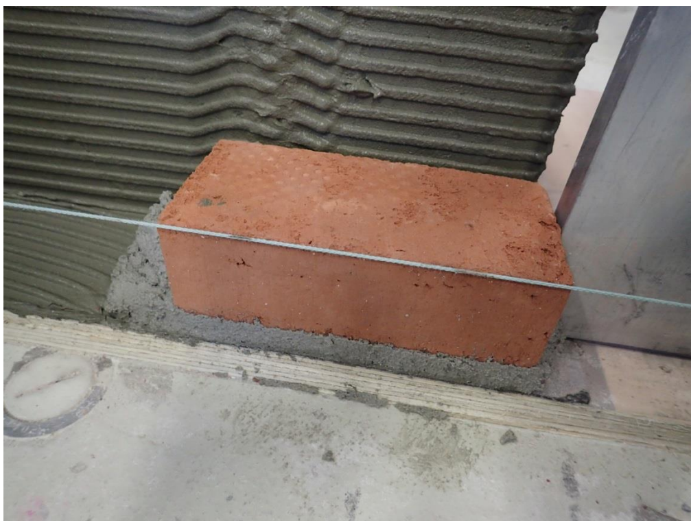
Foto 12. Der opmures med den nye 78 mm mursten.
