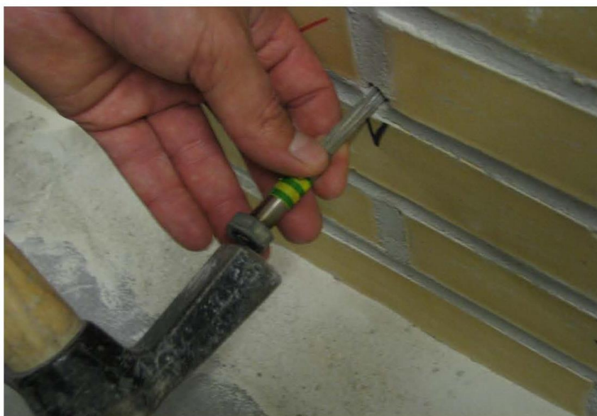
Figur 5. Krydsbor bankes normalt 20-30 mm ind i fugen.
