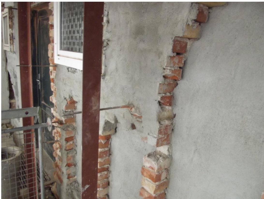
Foto 1. Billedet her er taget på stedet for den aktuelle renoveringscase. Princippet i fastgørelsen på figuren øverst på siden kan se således ud i virkeligheden.
