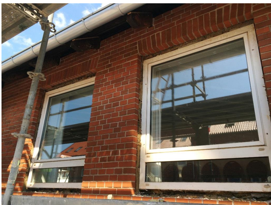
Foto 25: Vinduerne ligger tilbage i facaden.
