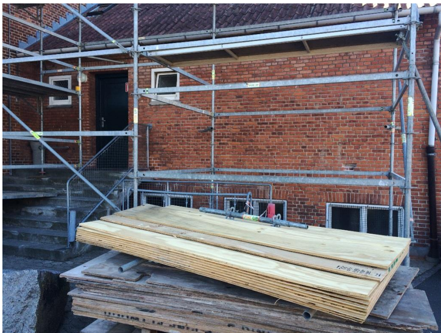
Foto 9: Opsætning af stilladser.
