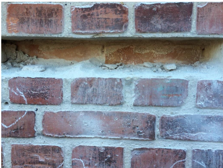
Foto 5: Løberskifte midt i væggen.
