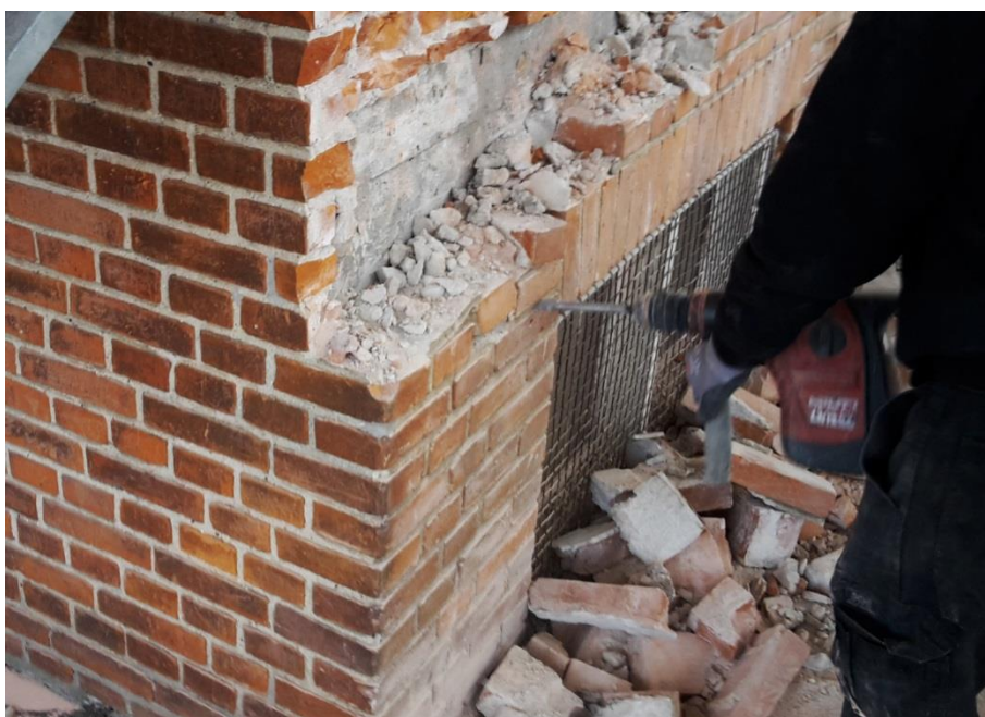
Foto 10: Nedrivning af formur opstartes. Der nedrives en facade/gavl ad gangen.
