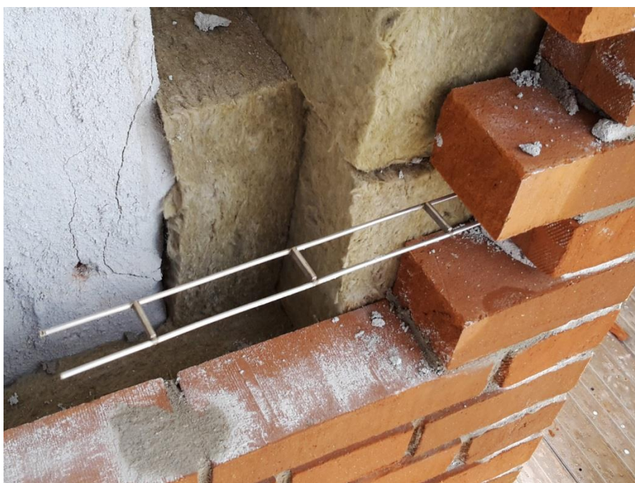
Foto 21: Hjørne armeres. Der er anvendt tilskårne hjørnestein, så der kan mures med normale murmål.
