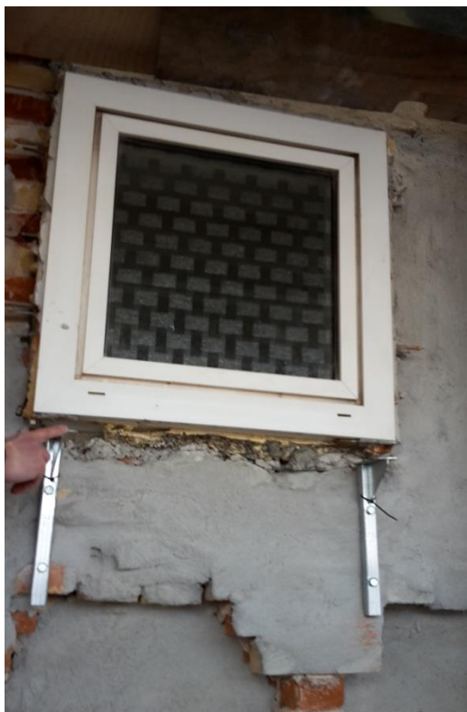
Foto 11: Vindue sidder i under nedrivning og fastgøres til bagmur, hvor dette er nødvendigt.
