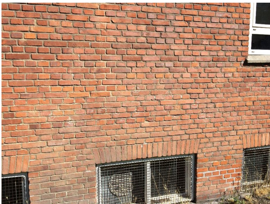
Foto 7: Eksisterende murværk, facade.
