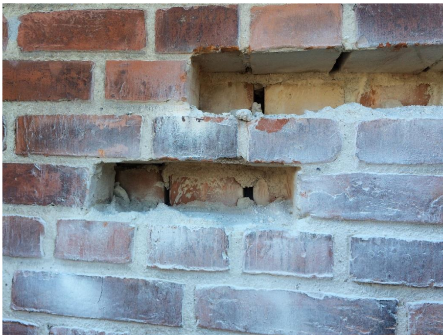
Foto 3: Bag løberskiftet er der hele sten som kopskifte i bagmuren.
