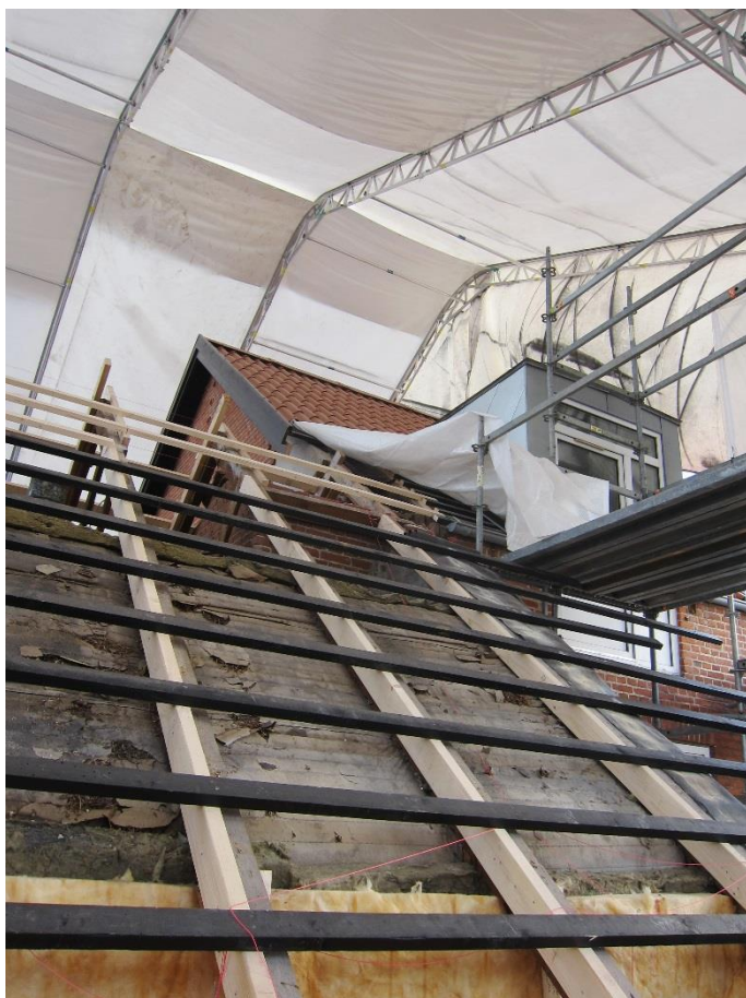
Foto 17: Totaloverdækning etableret.
