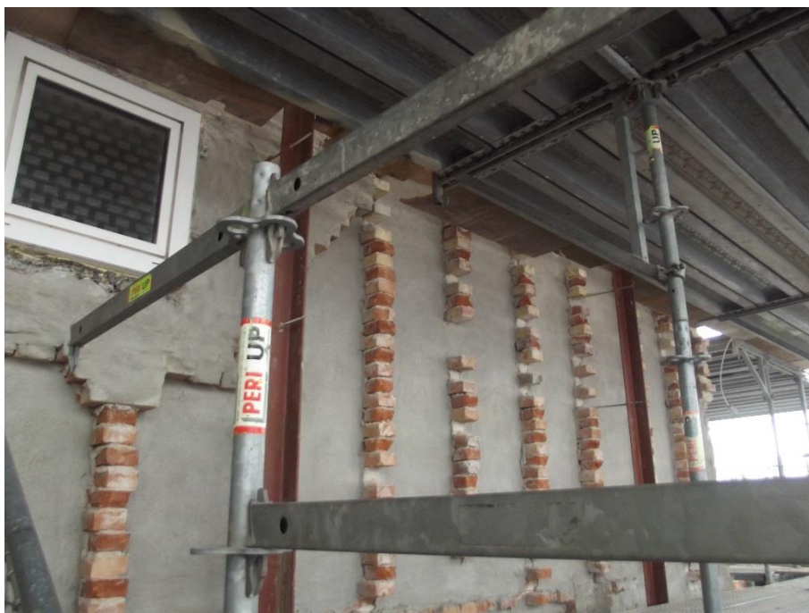
Foto 15: Bagmuren eftergås og pudses/berappes i dette tilfælde.
