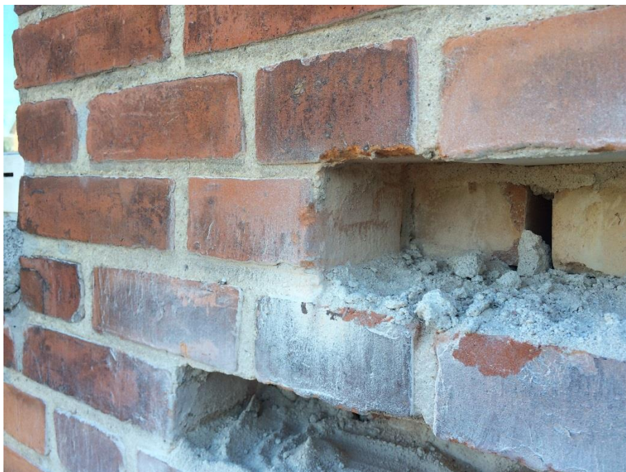
Foto 4: Kopskiftet er udført med \frac{3}{4} -sten i hver side.
