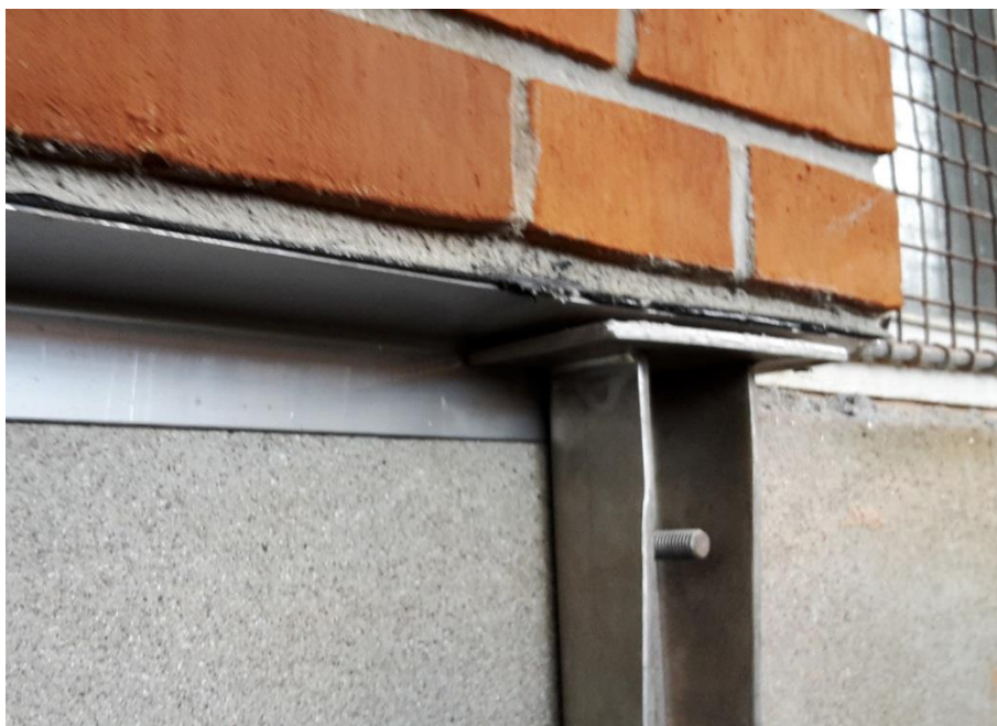
Foto 18: Konsoljern og vinkelskinne med nymuret facade.
