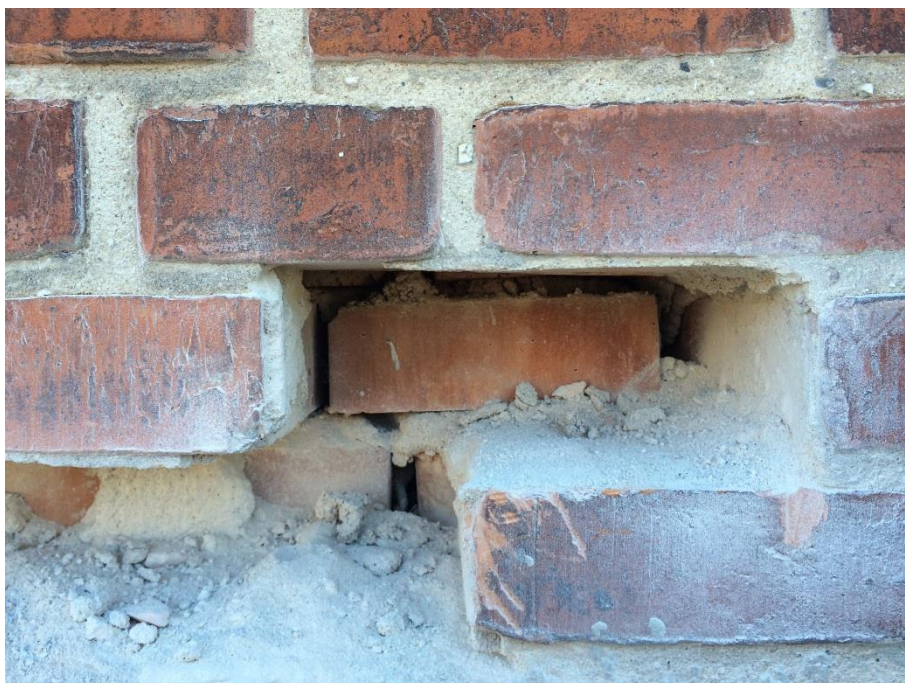
Foto 2: Bag \frac{3}{4} -sten ligger en tilsvarende \frac{3}{4} -sten på samme måde som løber.
