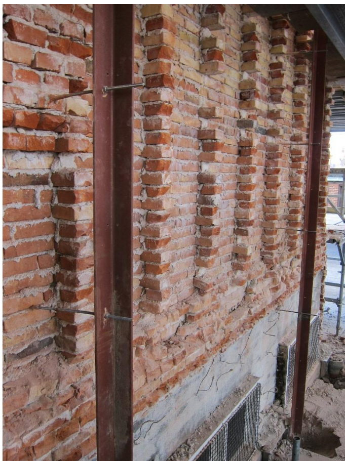
Foto 14: Formur er nedrevet, og afstivning etableret.
