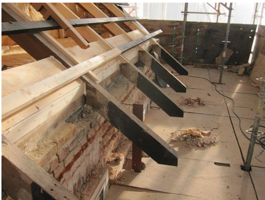
Foto 16: Taget pillet af, og formuren nedrevet.
