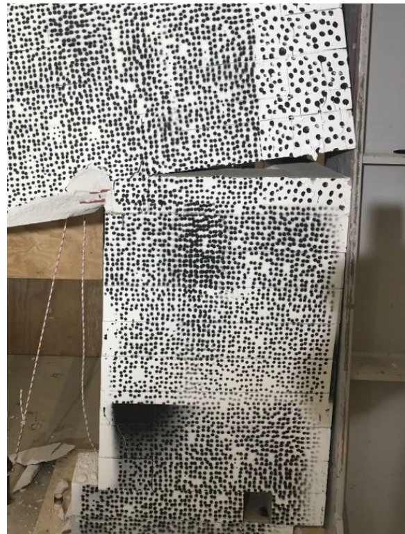
(d) Uplift right pillar
