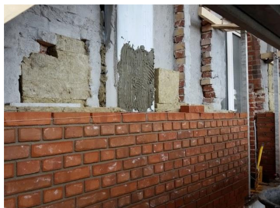
Facademur er afskrælet, bagmur klargjort, ny isolering sat op, og ny formur er under opførelse.
